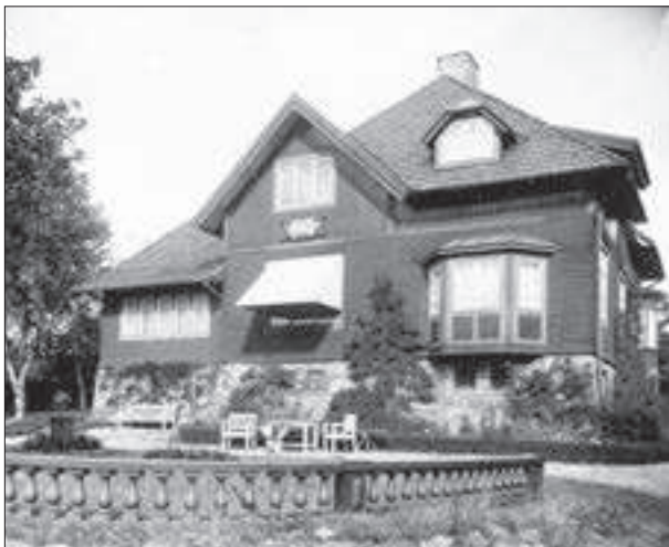
Bö villastad, Soltorpet (kv 10:3). Foto 1900-talets början.
