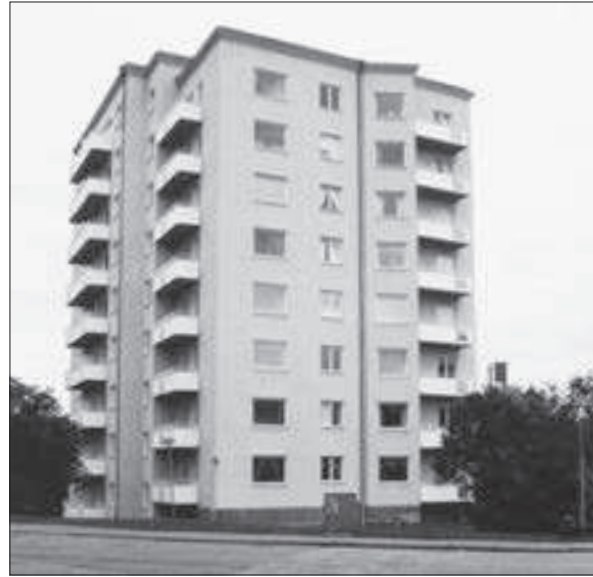
Dr Heymans Gata, kv 27. Punkthus med putsfasad.
