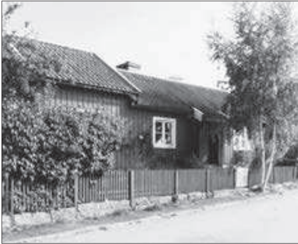
Äldre bostadshus, kv 76:71.
