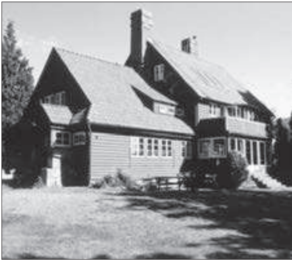
Käringbergsgatan 2B. Fasad mot väster.
