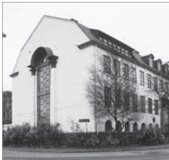
Huvudbyggnadens norra del. Fasader mot gatan.
