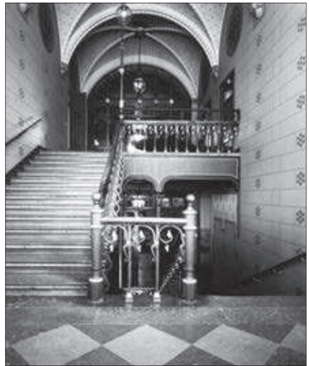
Trappbus i kanslibyggnaden.
