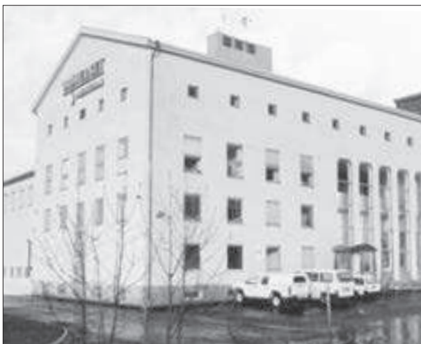
Alelyckans vattenverk II.
