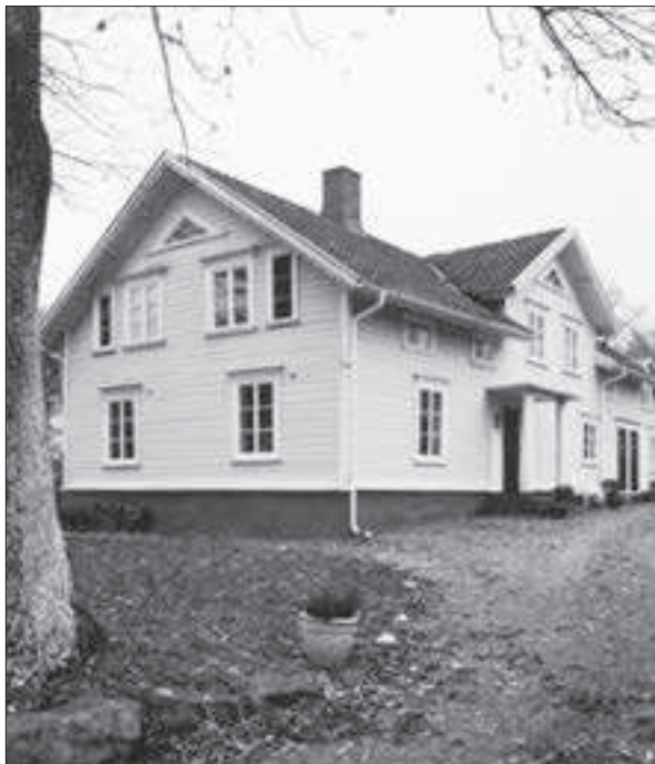
Eckrans gård, kv 52:5. Entrésidan.
