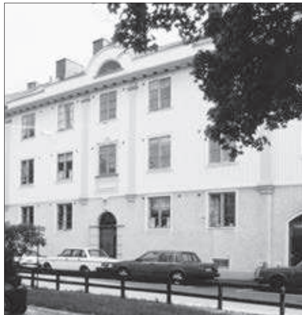
Kv 4 Kynnefjäll. Fasad mot Kungälvsgatan, kv 4:17–19.
