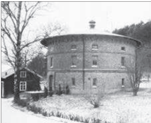
Vattenreservoaren. Till vänster skolhuset.
