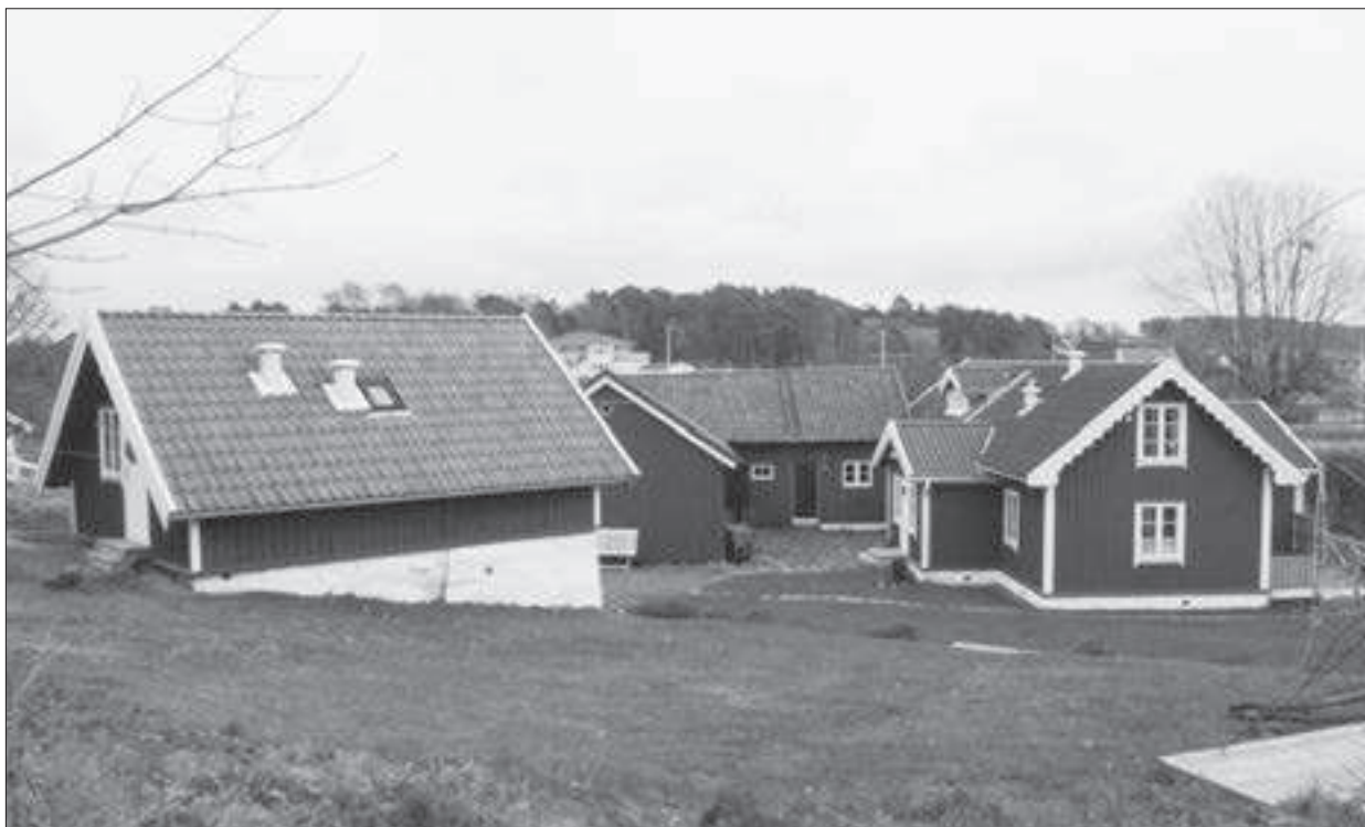
Högskärsgatan 2A sedd från väster.
