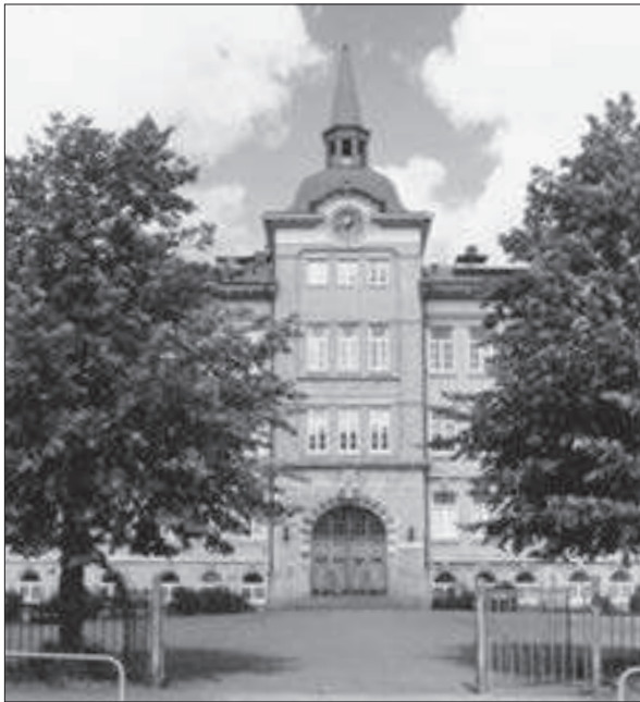
Ånässholan, huvudbyggnadens entré.
