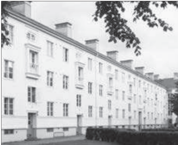
Kv 11, gården. Fasad med tilläggsisolering.
