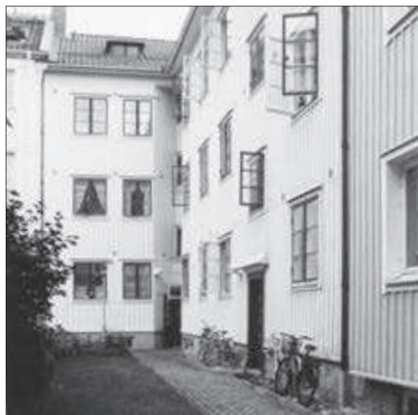
Gårdsinteriör Björcksgatan/Munkebäcksgatan (kv 38:20). Byggnaden har ursprungligt utseende med helt panelklädd fasad och spröjsade fönster mot gården.
