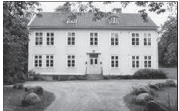
Vidkärrs gård, huvudbyggnaden sedd från allén.
