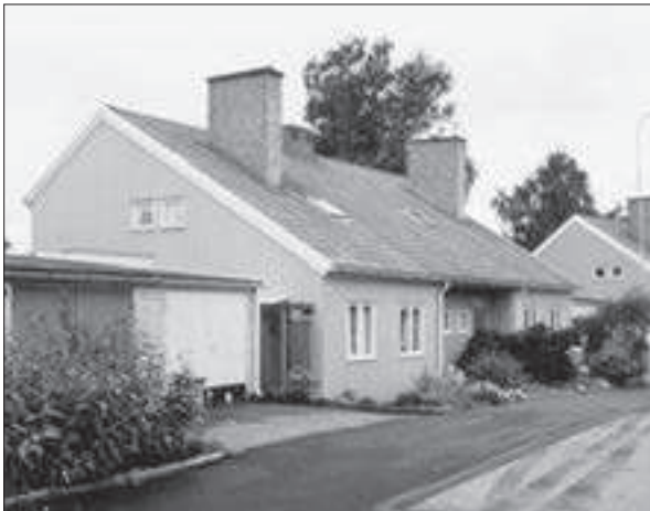
Parbus, kv 98. Gatufasader med indragna entréer.
