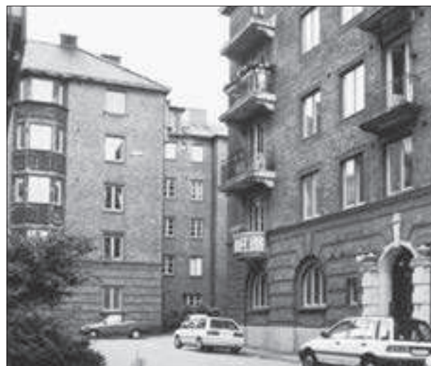
Kv 32, södra delen. Vy mot gården.
