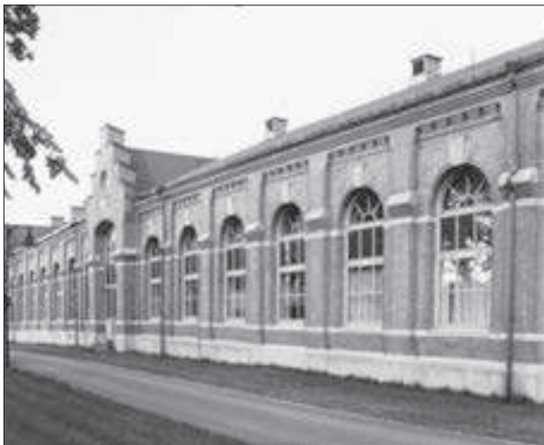
Alelyckans vattenverk I.
