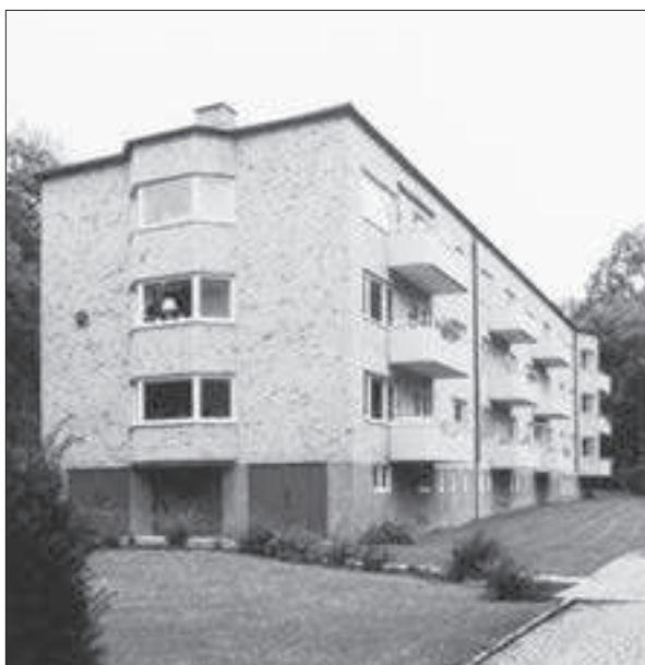
Iskällareliden, fasad mot bäckravinen.
