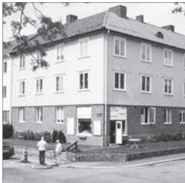
Björcksgatan (kv 38:15). Huset har ursprunglig bottenvåning av tegel, övervåningar klädda med ny panel och originalfönster utan spröjs.
