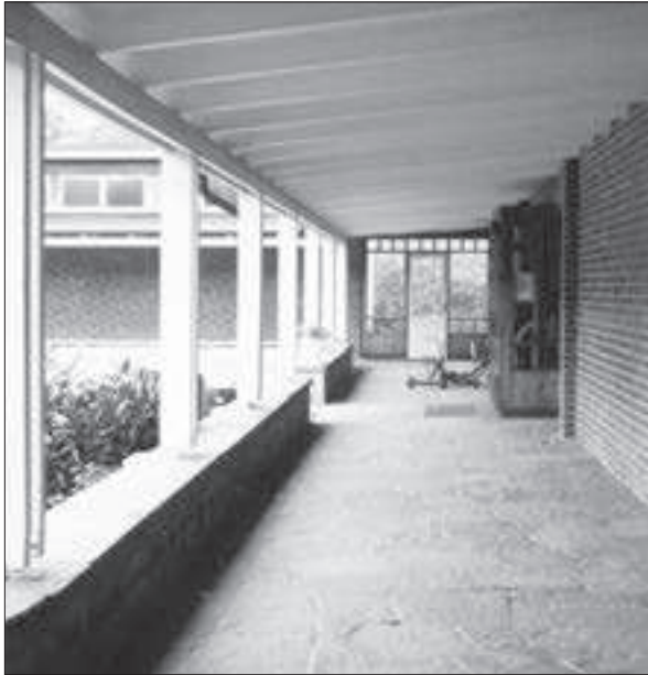
Mossebergsskolan. Loggia i östra längan.
