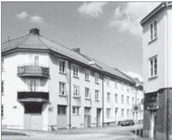
Kv 31 Neptun. Fasad mot Fabriksgatan.
