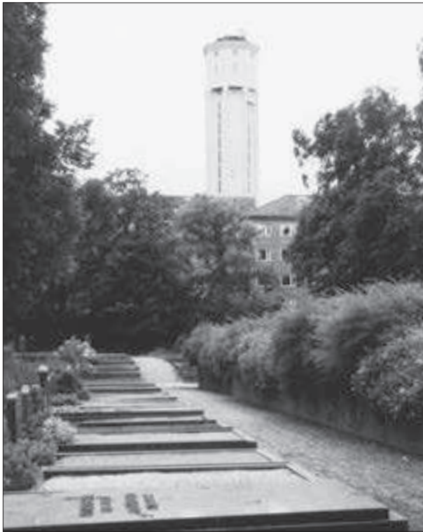
Lundens vattentorn, sett från norr. I förgrunden Tåns kyrkogård.
