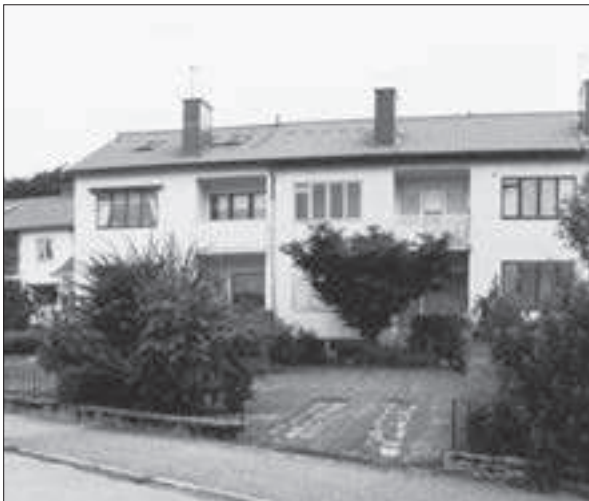
Kv 28, fasader mot trädgårdssidan.
