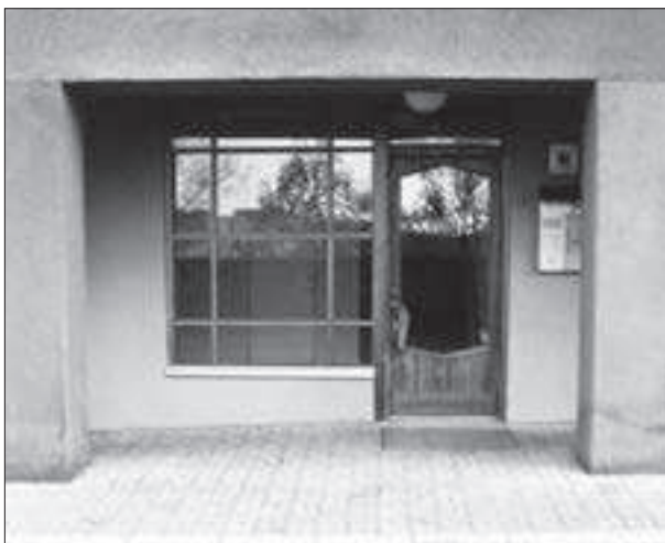
Dr Belfrages Gata, kv 24. Entréparti inne i loggian.
