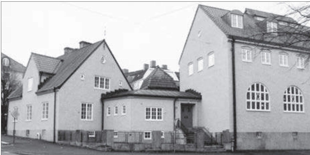
F d elstation, kv 5:2.
