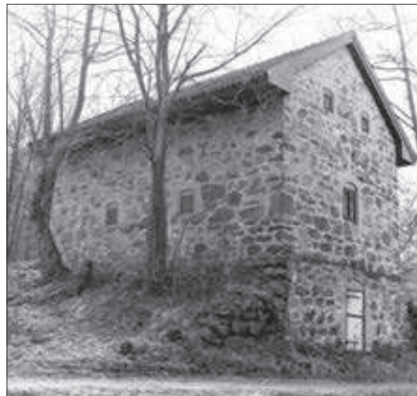
Magasinsbyggnad inom gårdens södra del.
