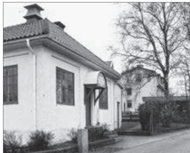
Hamnarbetarkontoret, entré mot Miragatan.
