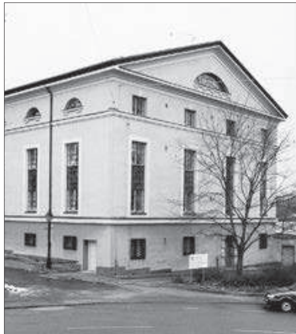
Majornas Elverk, fasad mot Chapmansgatan.
