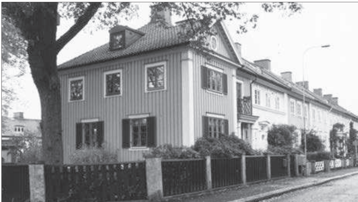
Radbuslänga, Torild Wulffsgatan, kv 8:19 m fl.
