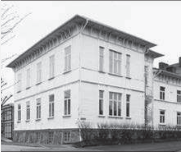
Lindholmsskolan, trähuset vid Verkmästaregatan.
