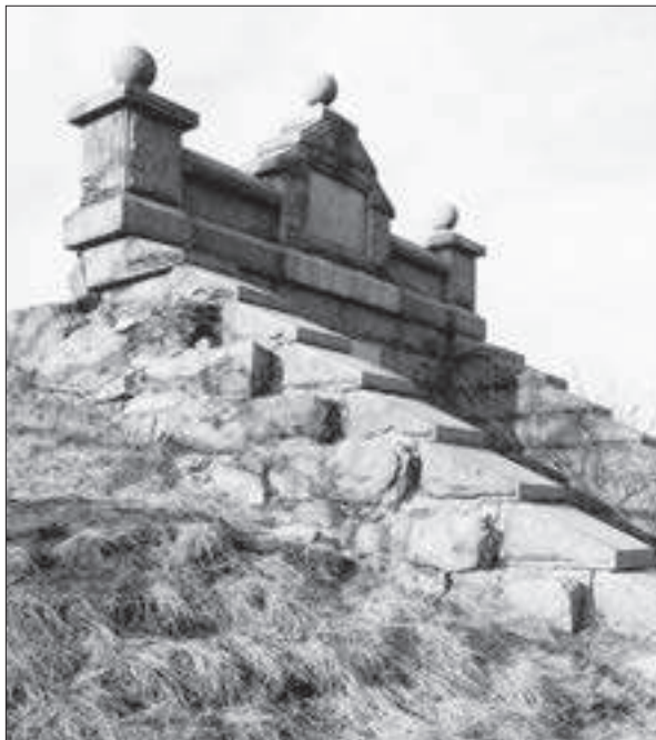
Vattenreservoaren vid Kabelgatan.
