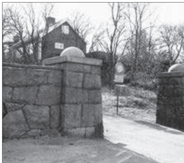
Entré och vaktstuga (16) i norr mot August Kobbsgatan.
