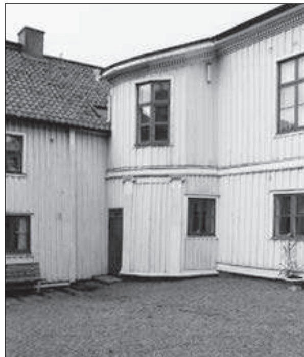
Gårdsfasadens hörnutbyggnad före fasadrenovering 1998.
