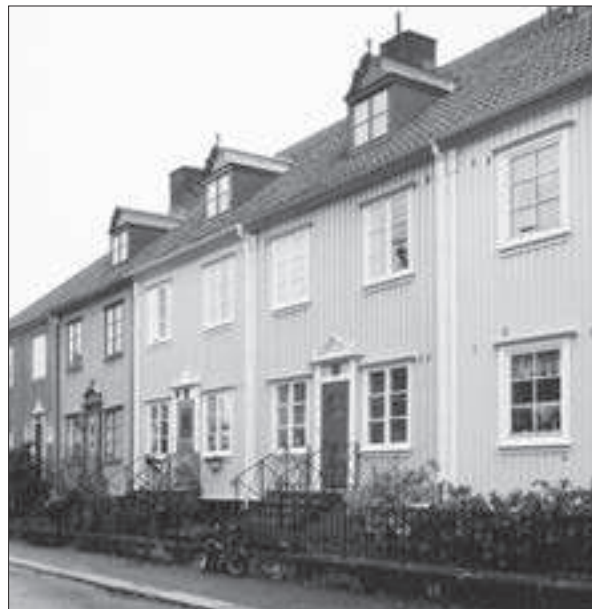
Radhuslänga, 1920-tal. Kv 9, Fyradalersgatan 44–36.
