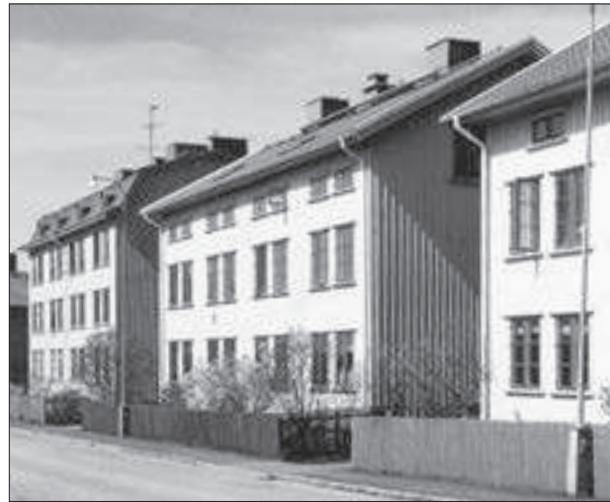
Förmansgatan, trähus i 2–3 våningar.
