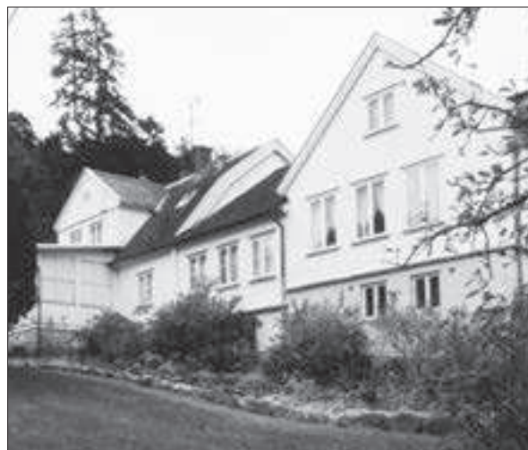
Huvudbyggnaden, norra sidan.
