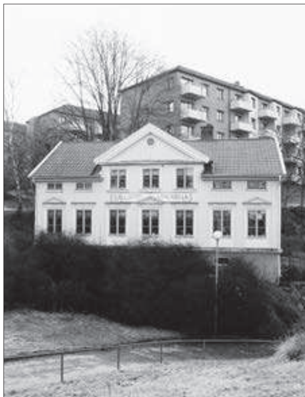
Kapten Hanssons hus sett från Chapmansgatan.
