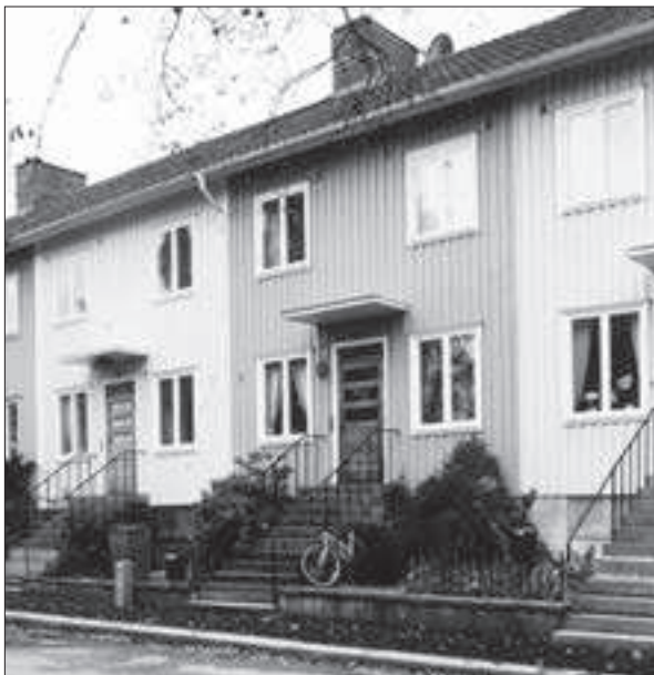
Radhuslänga, 1930-tal. Kv 11, Fyradalersgatan 66–72.
