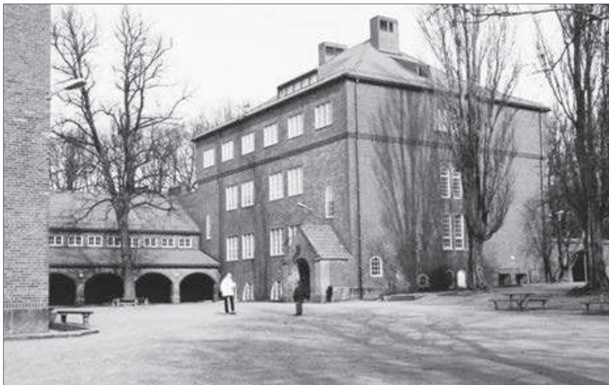
Rambergsskolans gård och loggia.
