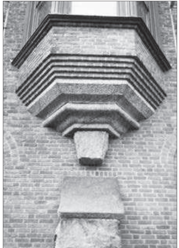
Östra fasaden, burspråkets nedre del.
