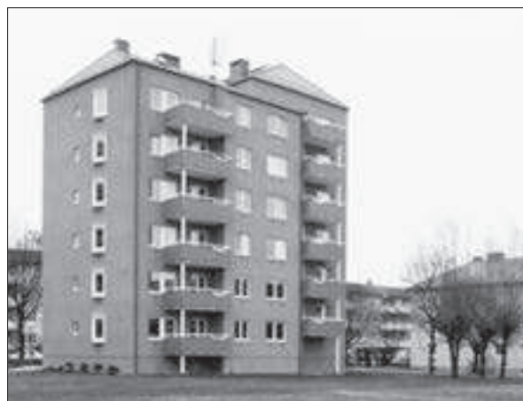
Grönebacken. Ombyggda bostadshus med nya putsfasader och utvidgade balkonger.
