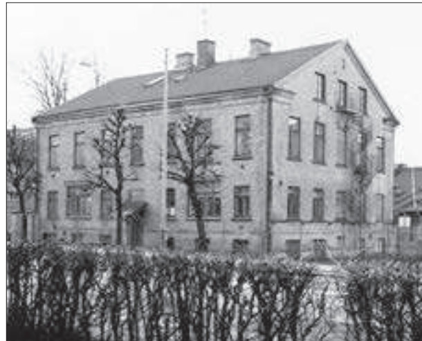
Djurgårdsskolan, stenhus från 1864.
