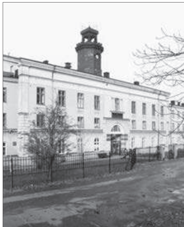
"Långa längan", mittpartiet med f d kanslilokaler. Huvudentrén från söder (11).
