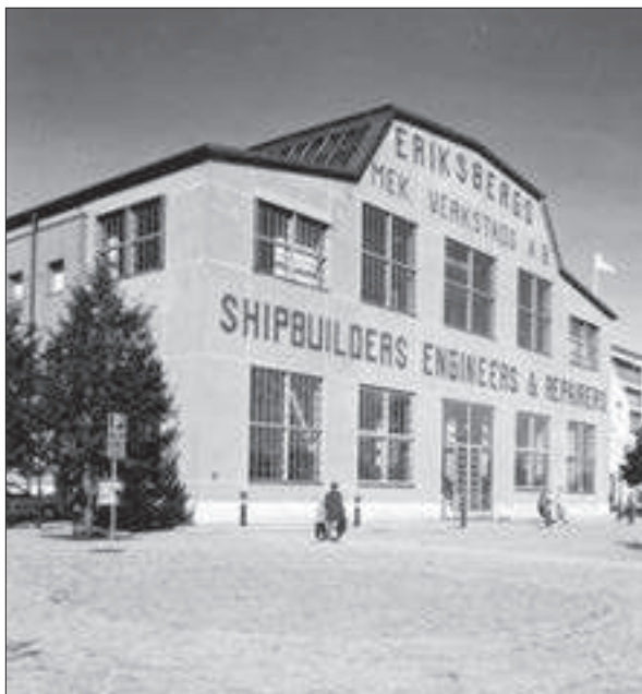
Gamla maskinverkstaden, fasad mot kajen.
