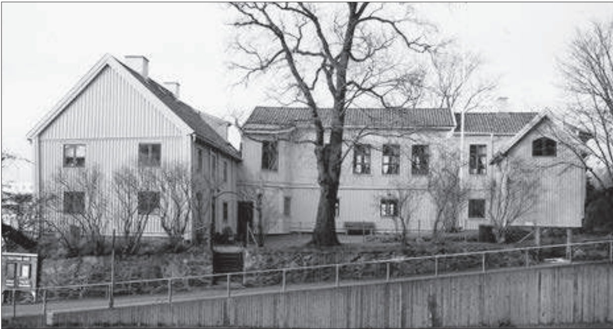
Kustens Vårdshus efter fasadrenovering 1998. Vy från Kustgatan. I förgrunden Oscarsledens betongkant.
