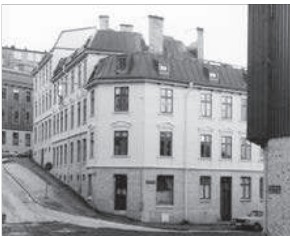
Kvarteret Pluto, södra delen mot Oljekvarnsgatan. I förgrunden ett yngre landshövdingehus.
