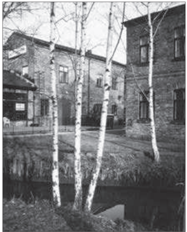
Kvillebäcken och fd Bult- och Nagelfabriken.
