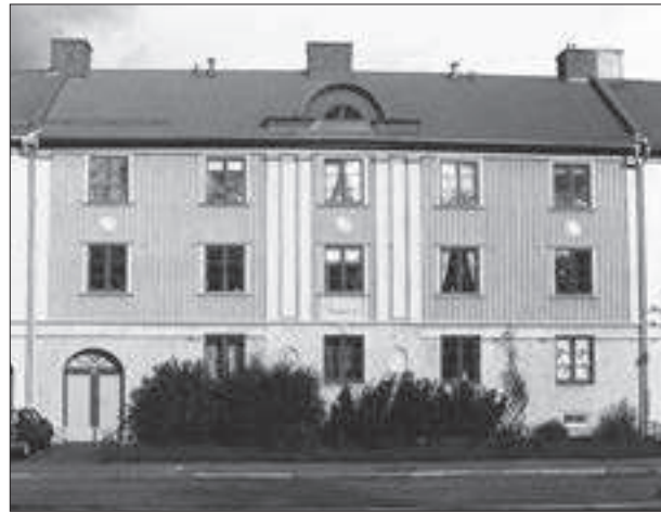
Kv 18, fasad mot Kennedygatan.
