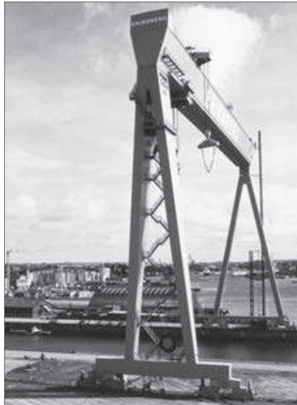
Eriksbergs bockkran sedd från väster.
