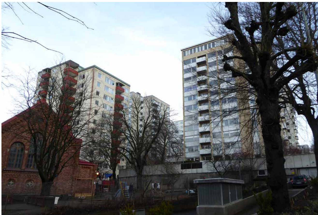
Höghusens volymuppbyggnad av två sammanfogade delar ger ovanliga lägenhetsformer. Foto: Sanja Peter
