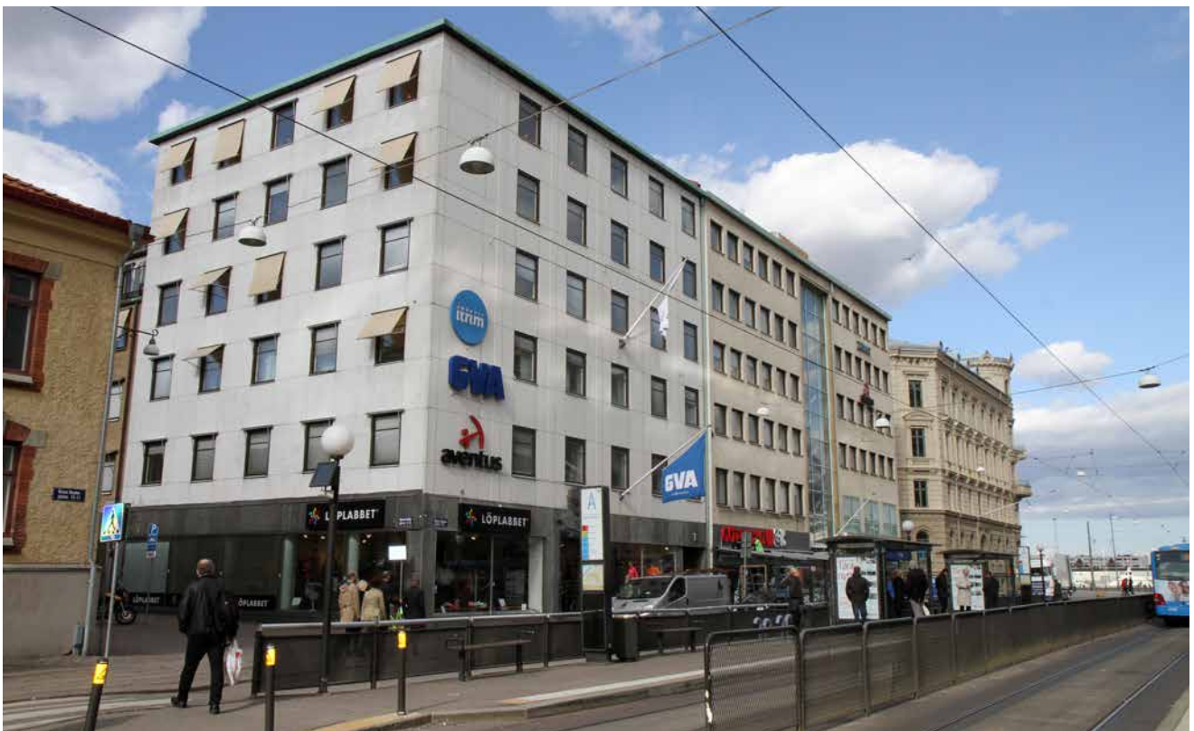
Broströmsföretagens hus vid Östra Hamngatan. Foto: Anna Reuter Metelius
