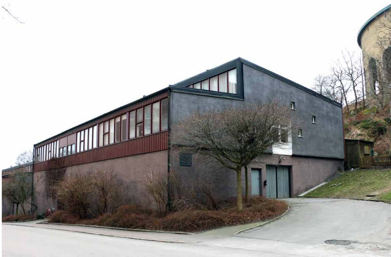
Ateljélägenheterna vid Syster Estrids gatan uppfördes åt verksamma vid Valands konstskola. Foto: Rickard Ribbås
