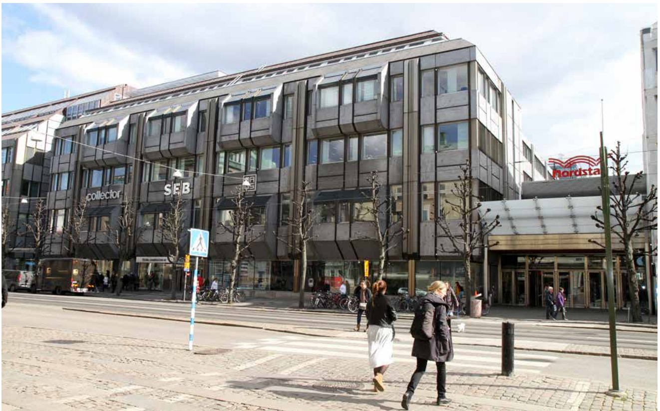
Del av kontorsbyggnaden sedd från Östra Hamngatan. Foto: Anna Reuter Metelius
