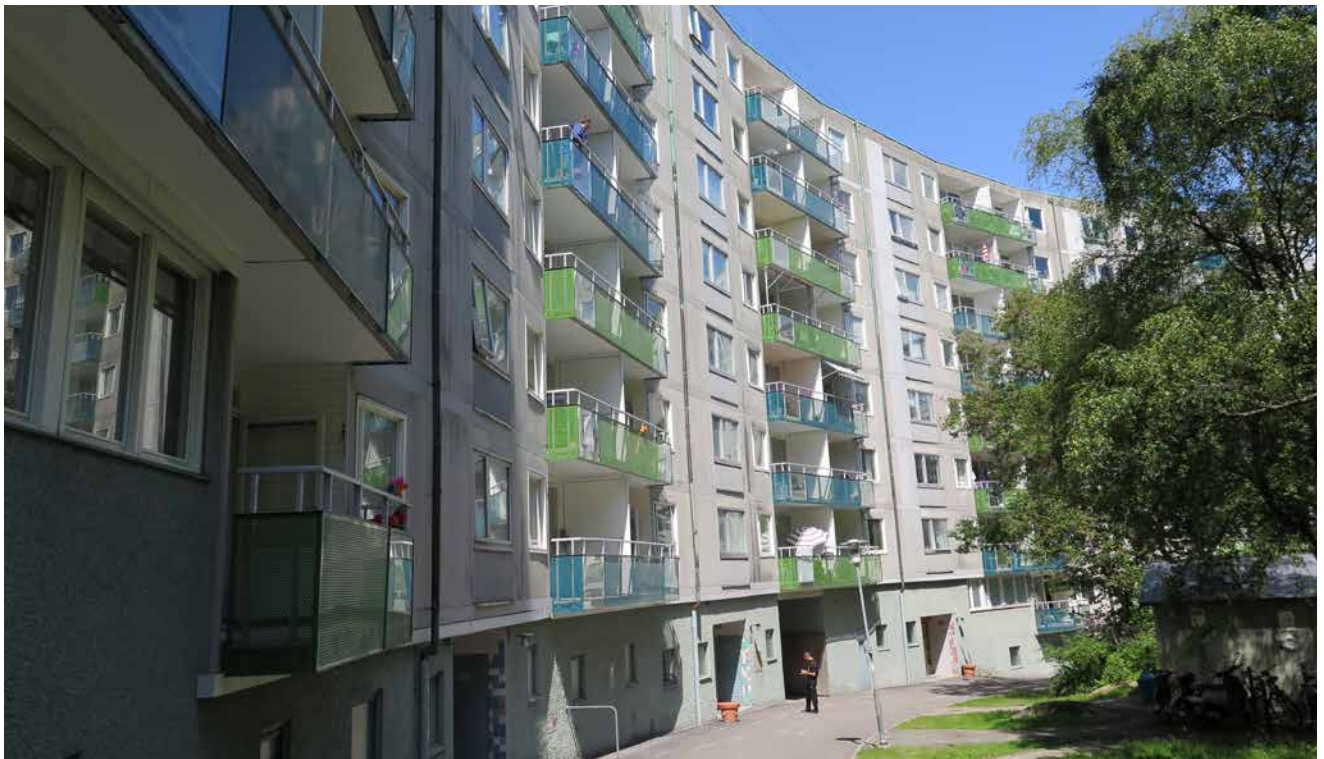
Husen har tilläggsisolerats och fått nya balkongfronter i blått och grönt. Foto: Sanja Peter
