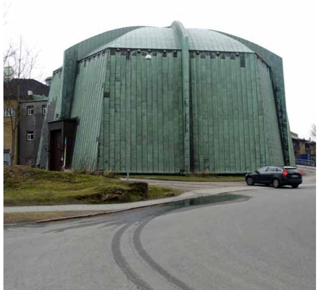
Kopparbunken vid Gibraltargatan
