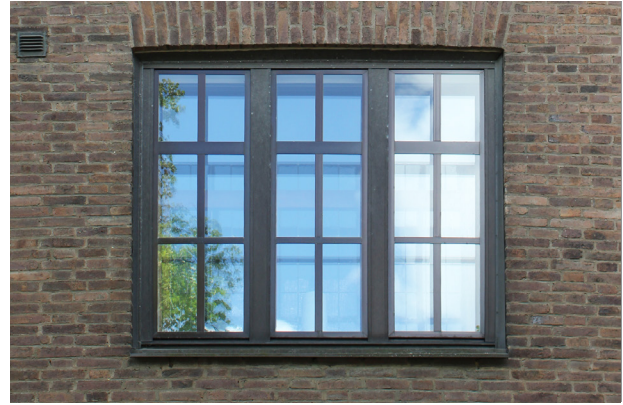
Ett fönster med en indelning där de falska tvärposterna inte kan efter skapa samma effekt som riktiga poster.
