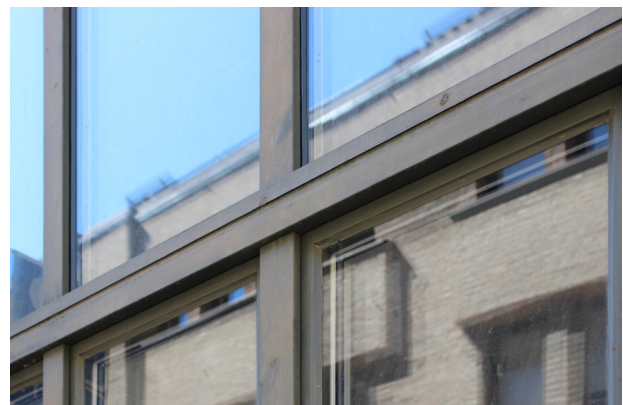
...jämfört med det utbytta fönstrets platta profiler, trots att dimensionerna egentligen är mindre.
