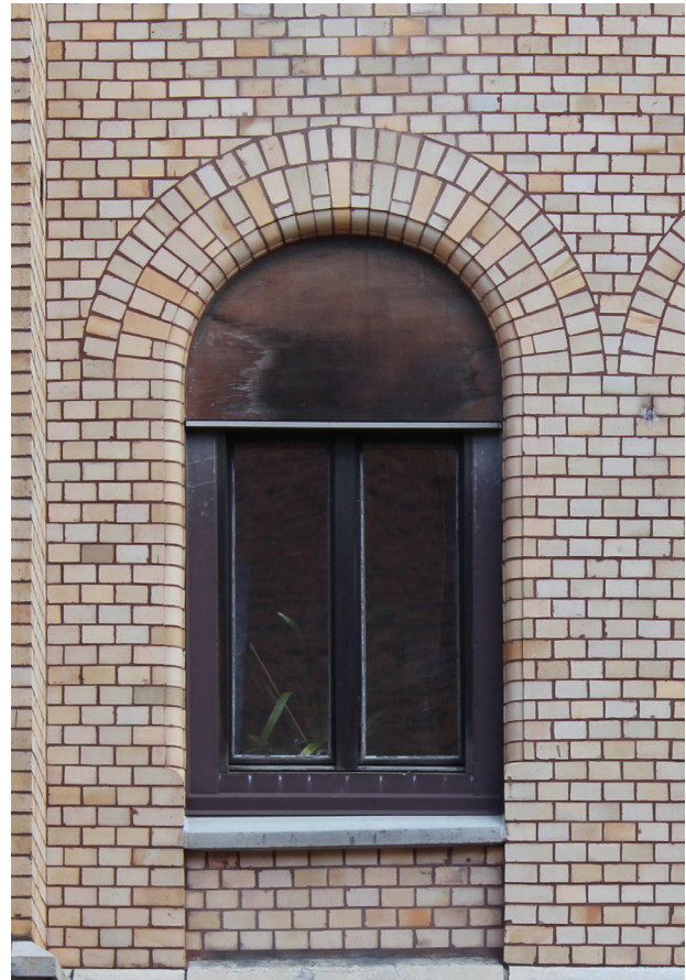
Fönster där originalfönstrets bågformade överdel har täckts med en skiva.
