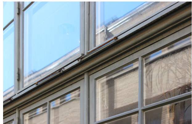
Originalfönstrets profilering och skillnaderna i djupled ger fönstret liv och lättar upp karmens visuella intryck...
