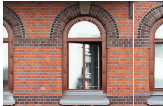
En falsk indelning av fönstret blir uppenbar i öppet läge och kan ge ett udda utseende.
