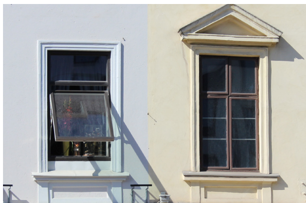
Ett glidhängt fönster i en äldre byggnad där originalfönstret varit sidohängtt.
