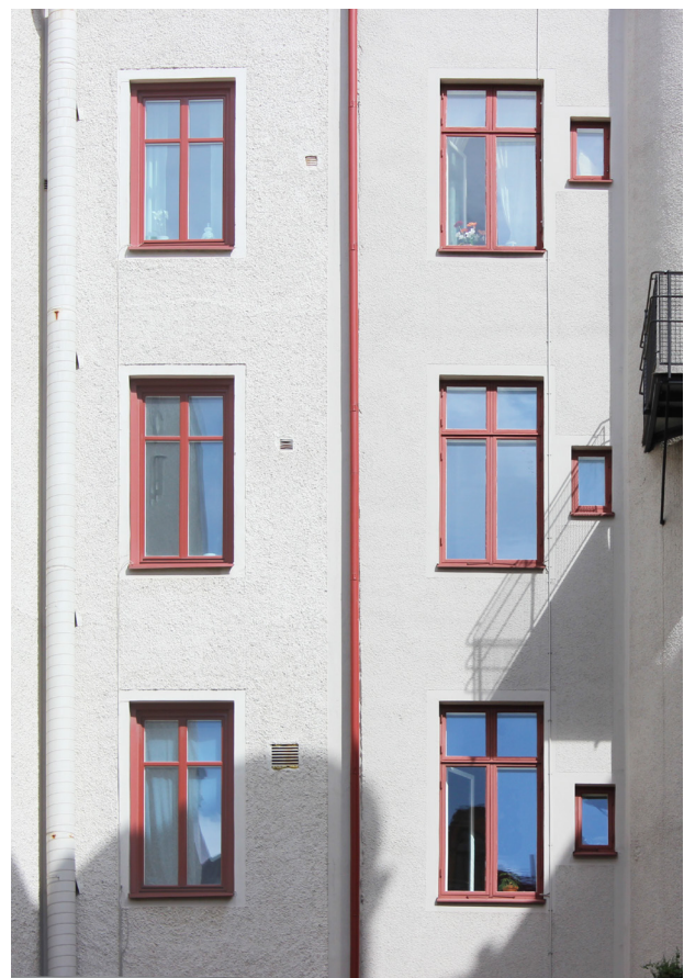
Fönster till vänster har fått grövre dimensioner och på grund av det ändrade proportioner och minskat ljusinsläpp.
