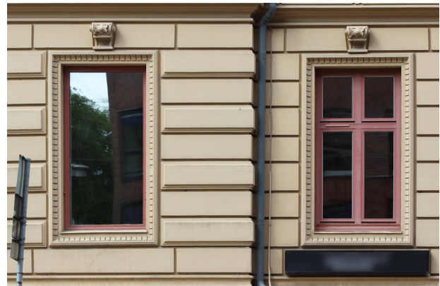
Ett fönster som har förlorat all ursprunglig indelning.
