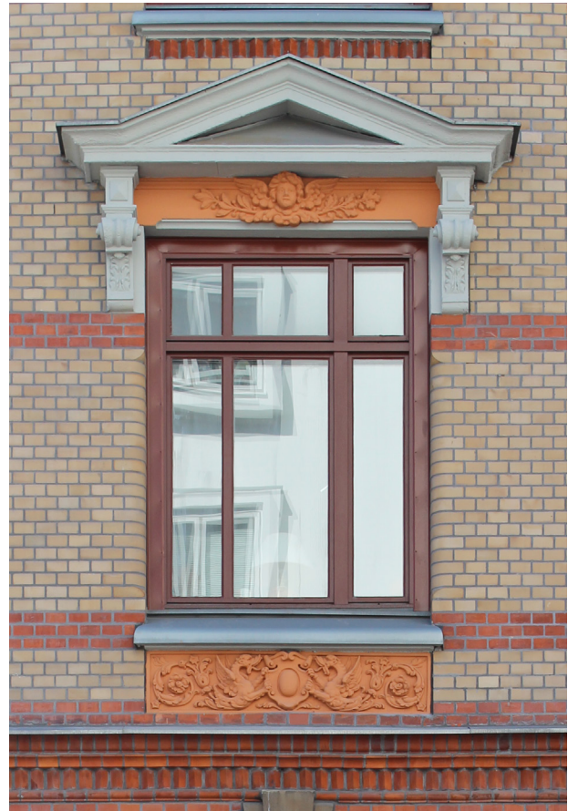
Ett fönster som fått både grövre dimensioner och förskjutna proportioner.
