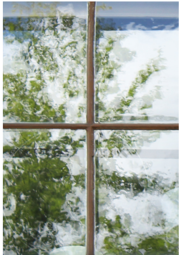
Reflektionen i ett äldre och ojämnt fönsterglas blir diffus och livfull.
