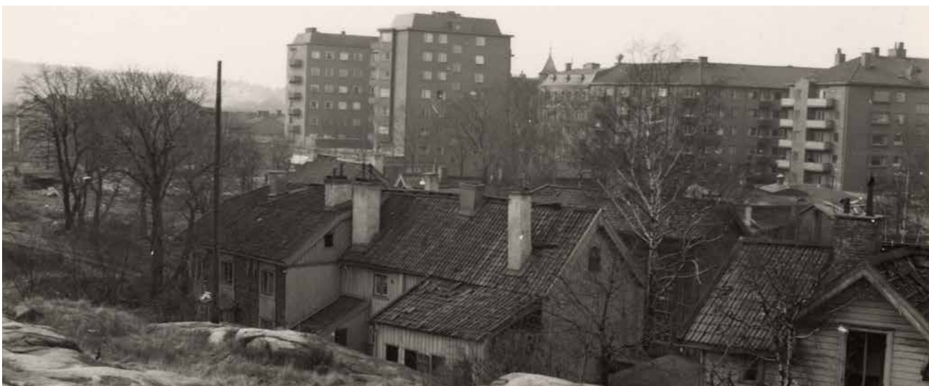
Gröna gatan under rivning 1959. Det nybyggda Chapmans torg i bakgrunden. Foto: Werner Goldbach. Göteborgs Stadsmuseums arkiv
