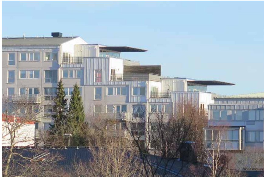
Upprustat bostadsområde i Gårdsten. Fasaderna har klätts in, fönstren bytts och husvolymerna trappades ned. Foto: Sanja Peter
