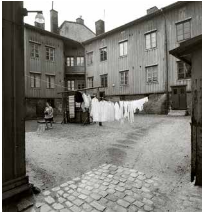
Innergård i Landala 1968, innan rivning. Foto: Stig Sjöstedt
