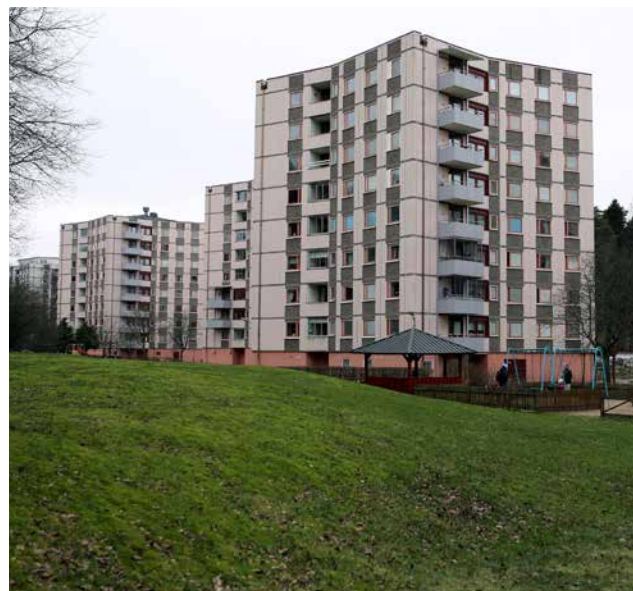
Stjärnhus på Teleskopgatan, det sista huset i norr är Stacken. Foto denna sida: Sanja Peter
