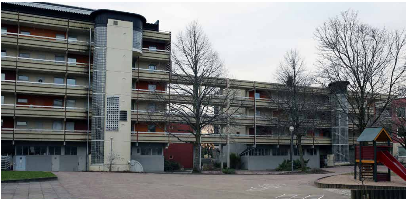
Glasade trapphusens funktion var att på kvällen lysa upp som lyktor. Foto: Sanja Peter
