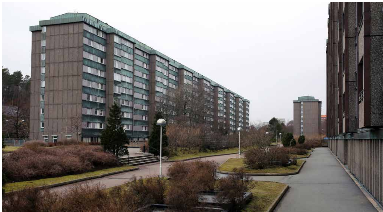
Prästgårdsängen är uppfört på ett P-hus varför det stora området har kunnat hållas bilfritt. Foto: Anna Reuter Metelius
