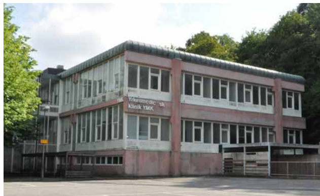
GAKO-huset innan rivning på 2010-talet.
