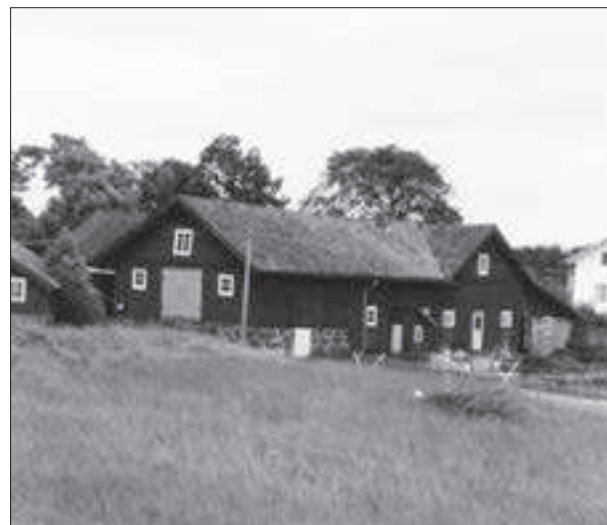
Kvisljungeby. Stor vinkelbyggd ekonomibygnad.
