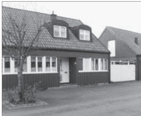
Kedjehus med ursprungliga vita tvåluftsfönster.
