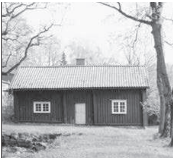
Hökälla, södra byggnaden.
