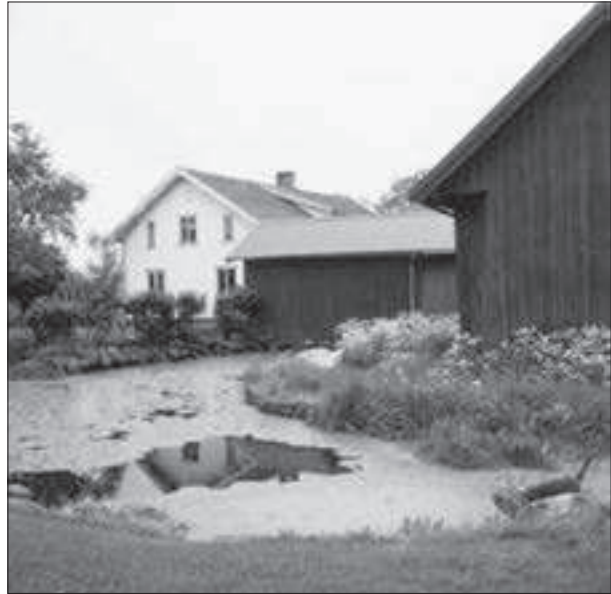
Öxnäs 1:5 från öster. Bostadsbus på dubbel bredd och en stor vinkelbyggd ekonomibygnad intill en damm.
