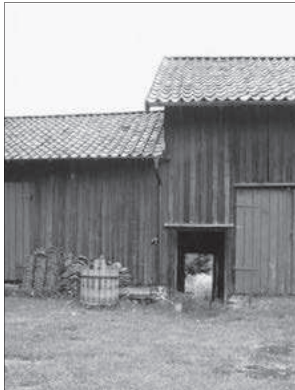
Ekonomibyggnadens västra del med passage ut mot gårdens ägor.
