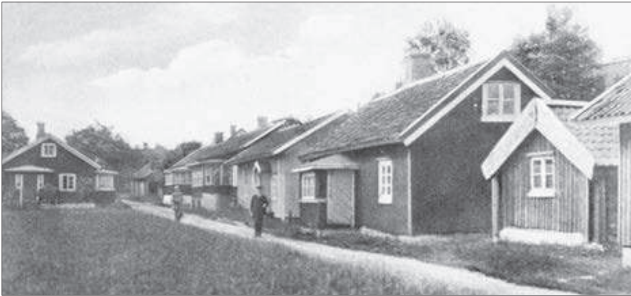
Brännö, huvudvägens mittparti vid början av 1900-talet. Det låga huset med gaveln mot vägen har flyttats till Styrso och är nu bemygdssstuga. Intill ligger "Onkels".
