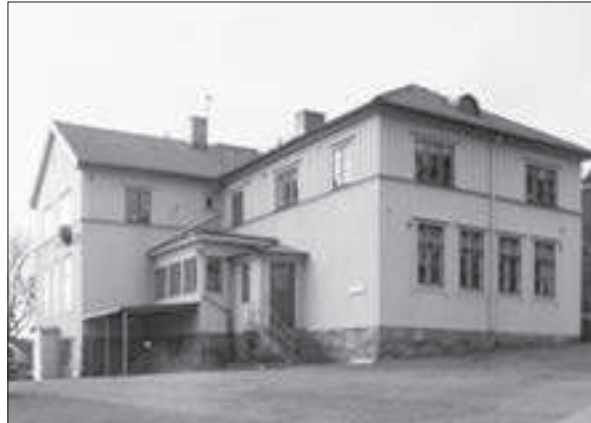
Skolans yngre hus. Byggt som folkskola. Efter tillbyggnaden 1919 folkskola, småskola och lärarbostad.
