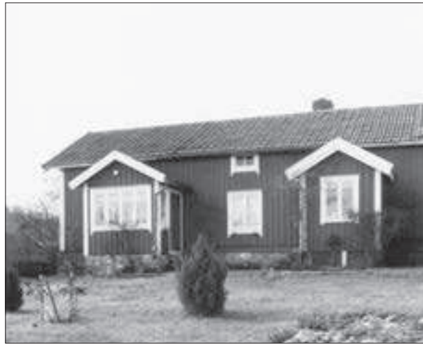
Torslanda Östergård 5:4, östra fasaden.
