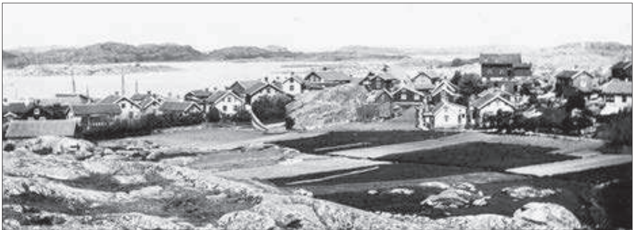
Styrösö Tången, vy från landsidan. I förgrunden åkermark som är i bruk. Mot vattnet tätt placerade bostadshus, utbus och sjöbodan. Foto 1900-talets början.
