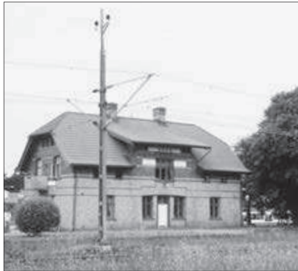
Stationshuset i Säve, från öster.
