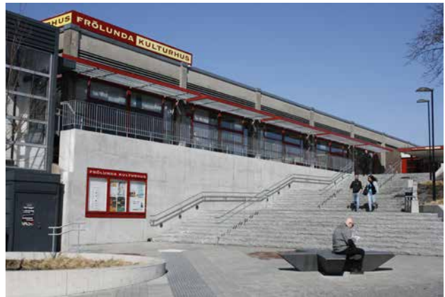
Kulturhusets entrétrappa, ombyggd i början av 2000-talet.
