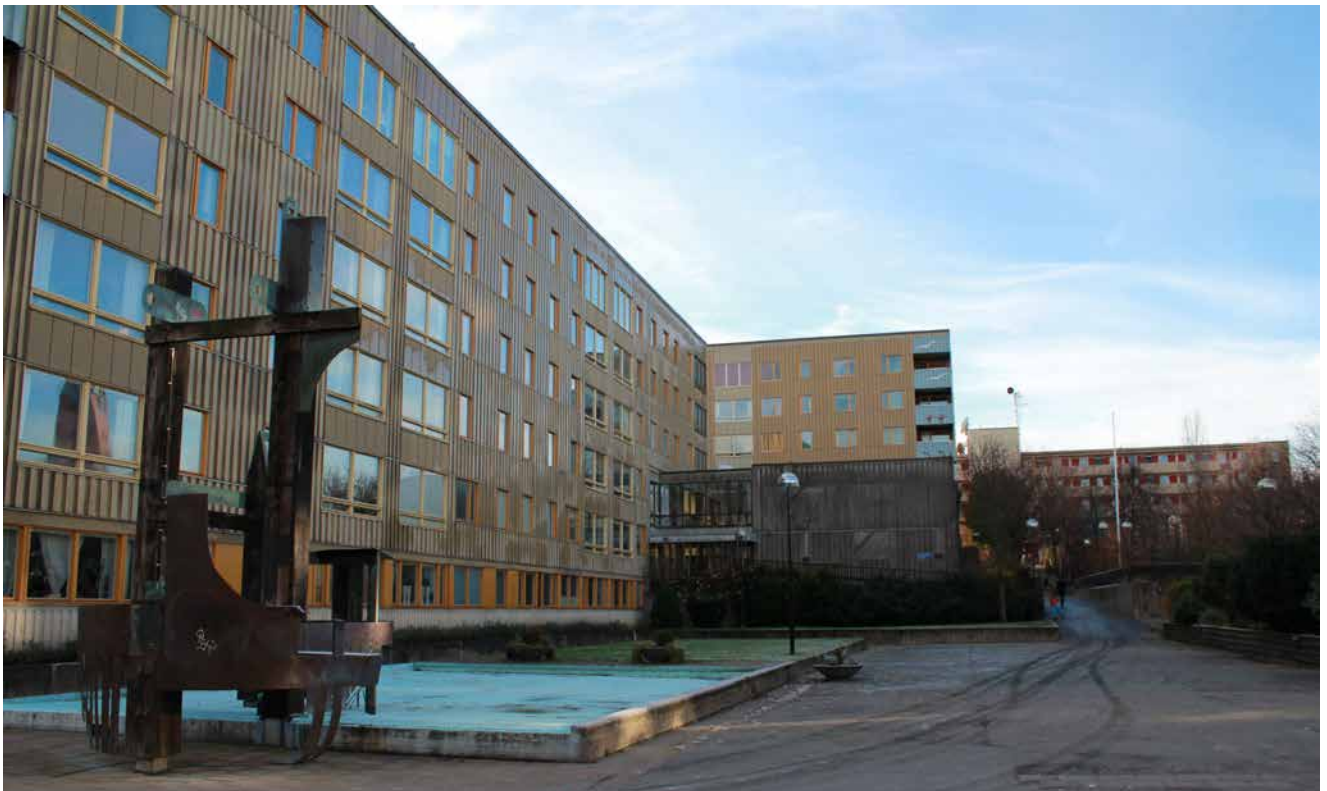
Klingners plats innan fasadändringar gjordes. Foto denna sida: Sanja Peter
