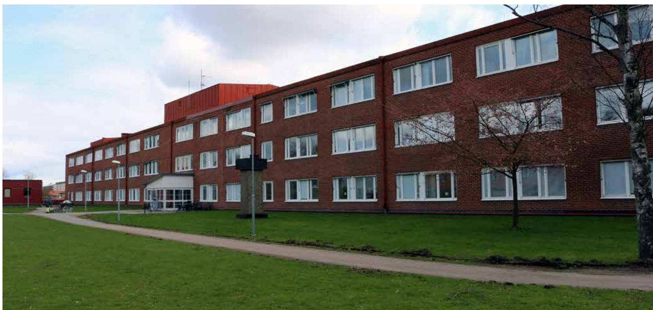
Högsbo Sjukhus innehåller byggnader från olika perioder. Foto: Rickard Ribbås
