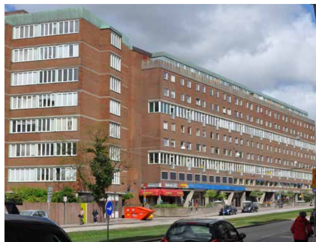
Majviken 3 är det sist uppförda huset inom kvarteret och det som behållit den ursprungliga fasaden. Till vänster i bilden syns Majviken 2 innan fasadändringen. Foto: Anette Lindgren
