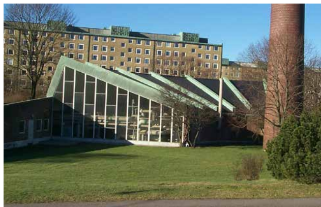
Panncentralen, byggd 1960. Foto: Sanja Peter
