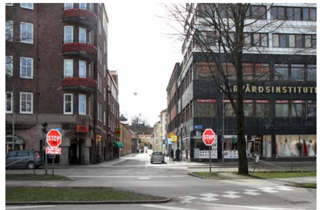
Baksidan av Ny Tids hus. Byggnadsvolymen är anpassad till bebyggelsen i Haga. Vy längs Mellangatan från norr.
