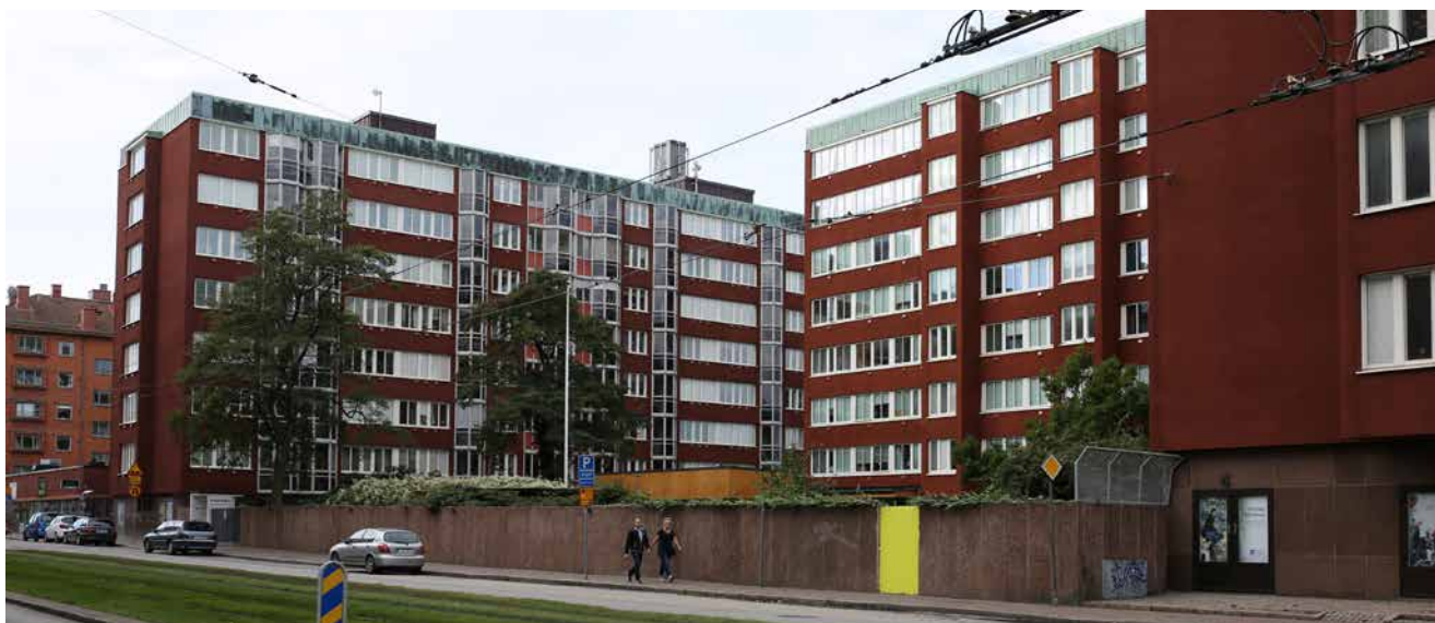
Majviken, Göteborgs första kooperativhusbygge, här efter tilläggsisolering och ny puts på fasaderna. Foto: Anna Reuter Metelius
