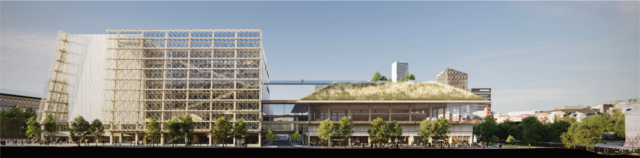
Vy över södra fasaden
