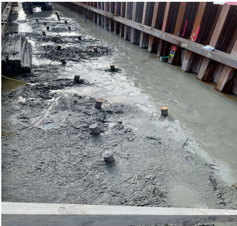
Figur 10. Pluggade stålörspålar under befintlig entreprenad. Foto: Skanska
