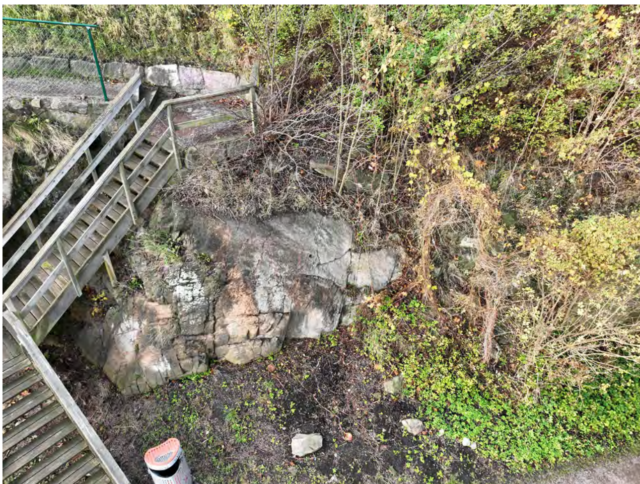
Figur 34. Objekt 12 stenkonstruktion. Mot nordväst.
