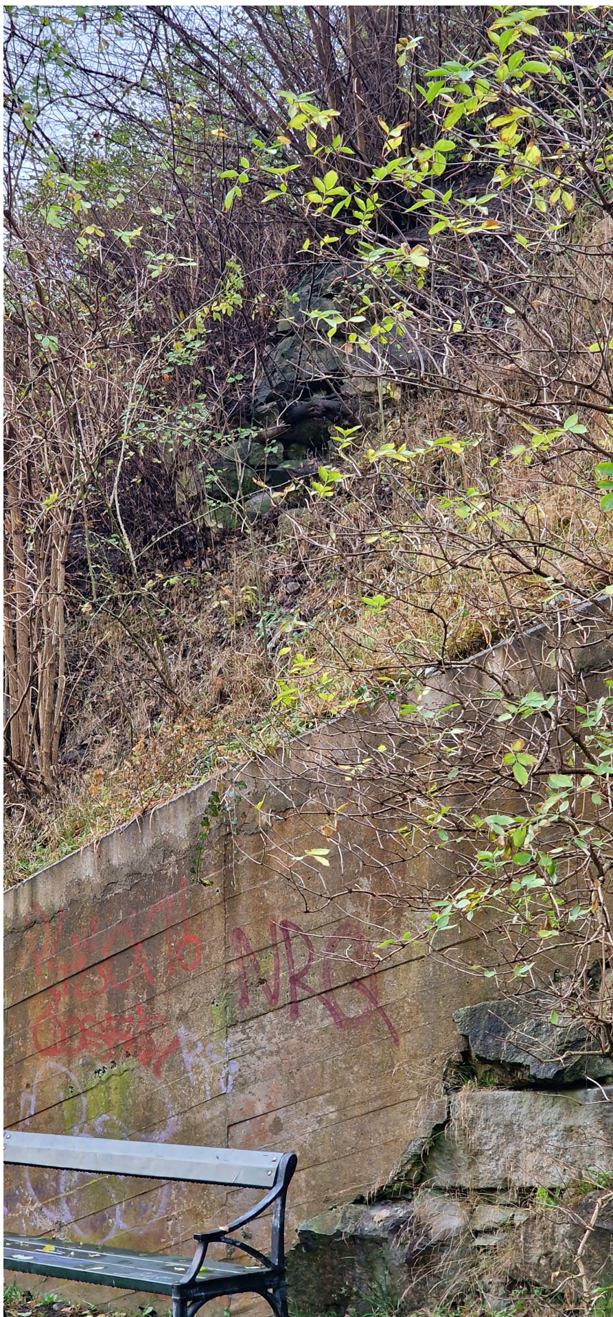
Figur 35. Objekt 6 under betongsargen och 10 på högre nivå i slänten. Mot sydsydväst.
