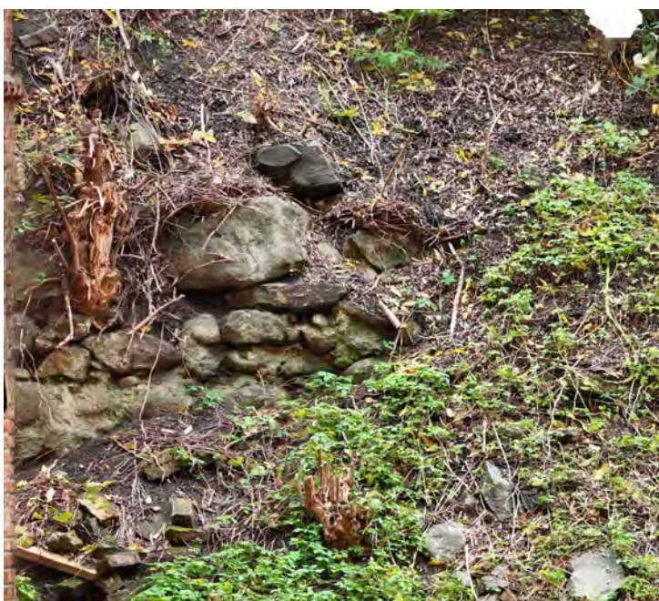
Figur 53. Foto hämtat ur 3D-model. Stenmur Objekt 22. Mot sydsydöst.
