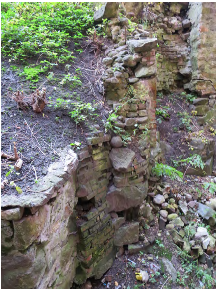
Figur 19. Objekt 3 som visar ett område där restaurering med modernt tegel stöter emot terrassmuren. Mot sydväst.
