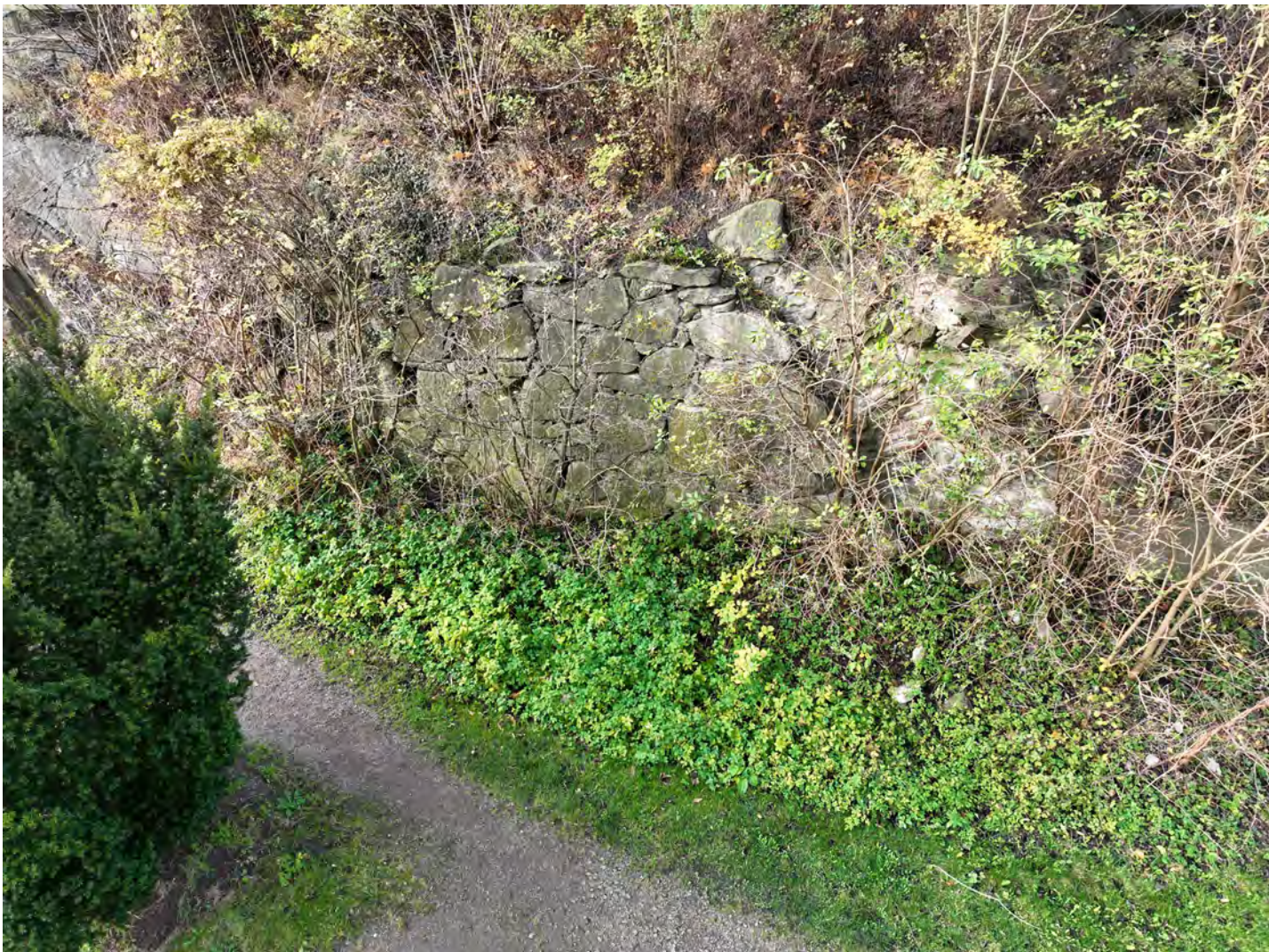
Figur 29. Foto från drönare. Objekt 7, 8 och 9. Mot väster.
