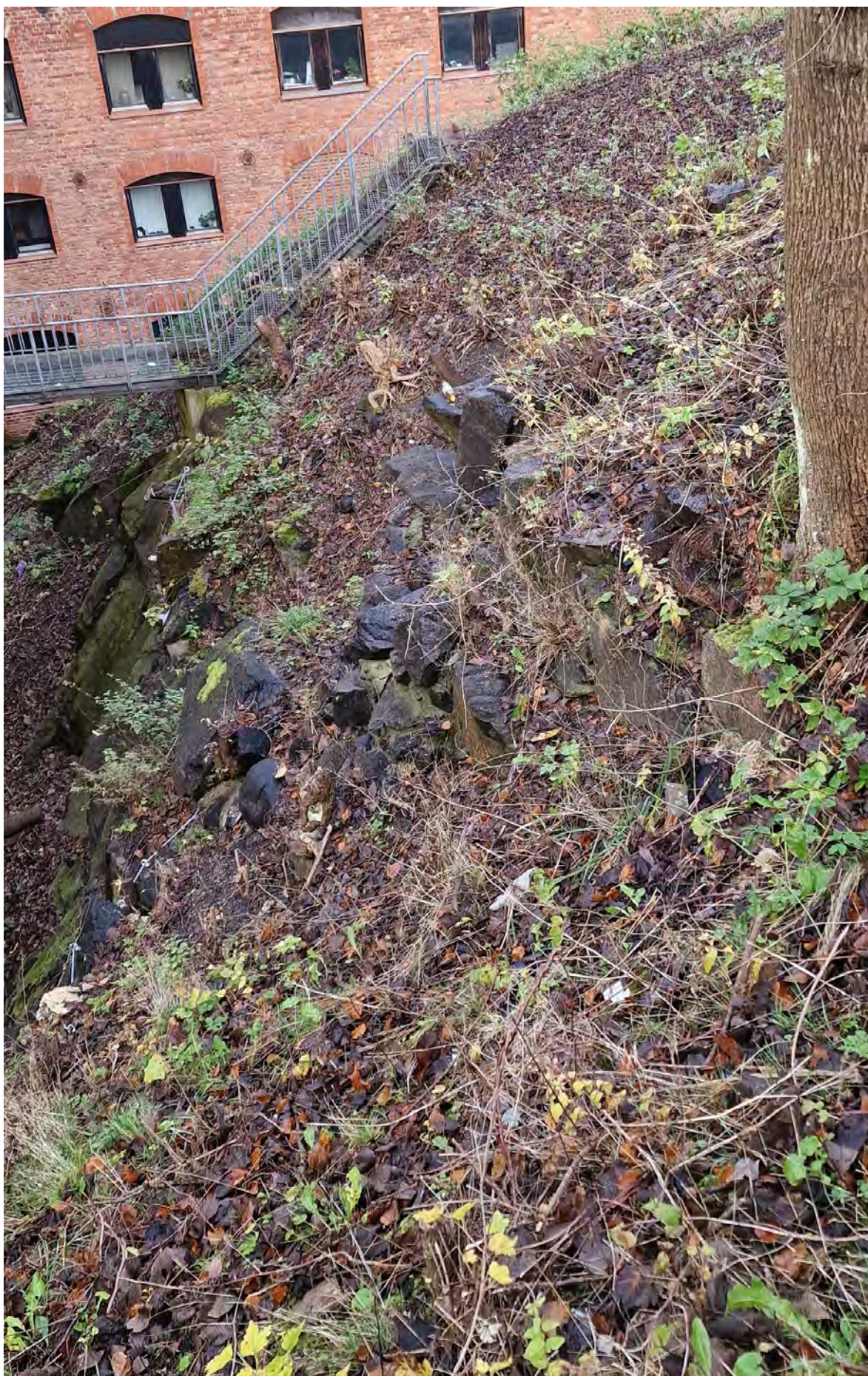
Figur 47. Stenmurar Objekt 16 och 17. Vid betongfästet för stålbron ligger Objekt 19. Mot norr.
