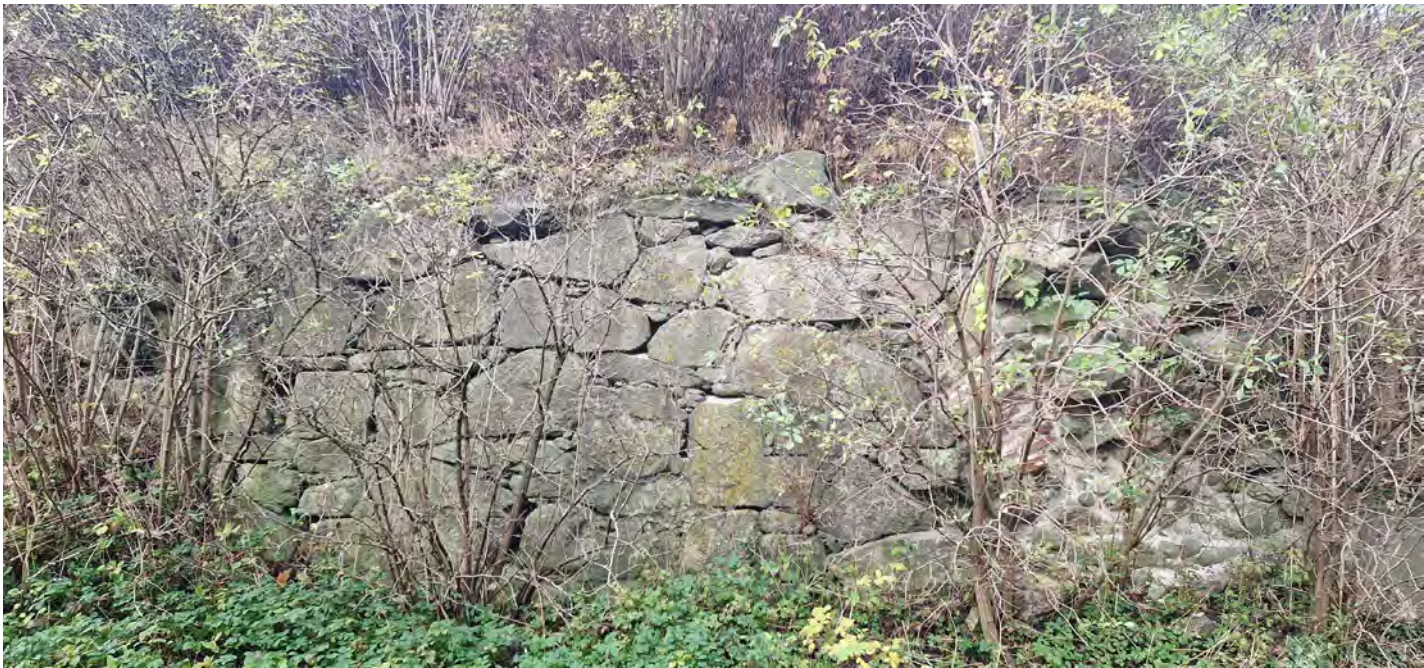
Figur 28. Objekt 7, 8 och 9. Kasemattens östra gavels insida (Objekt 7) och nordöstra hörn med rester av tegelvalv till höger i bild (Objekt 9) samt rester av den utanpåliggande norra långsidan till kasematten (Objekt 8). Mot väster.
