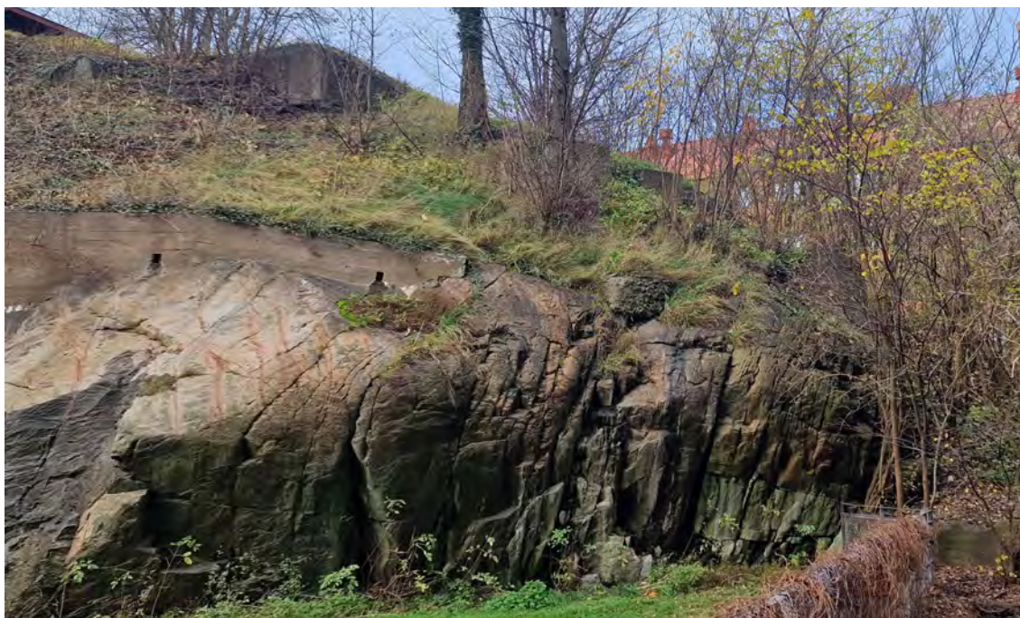
Figur 25. Objekt 5 består av tre synliga nivåer med betongkonstruktioner. Konstruktionerna har hört till Porterbryggeriet. Mot nordväst.
