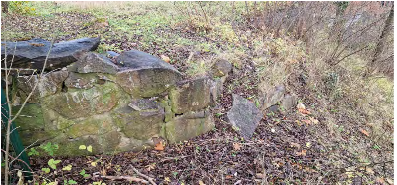
Figur 65. Foto av slottslämningarna Objekt 23. I bilden syns murrester efter den nordöstra rundeln till slottets kapell. En av stenarna har pressats ut av vegetation. Mot norr.
