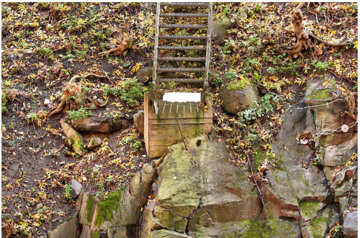
Figur 46. Foto hämtat ur 3D-model. Stenkonstruktion Objekt 19. Mot nordväst.
