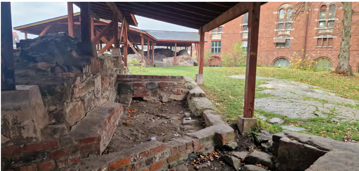
Figur 61. Foto av slottslämningarna Objekt 23 under det norra skyddstaket. Foto av rum med uppbrutet golv. Mot sydsydväst.
