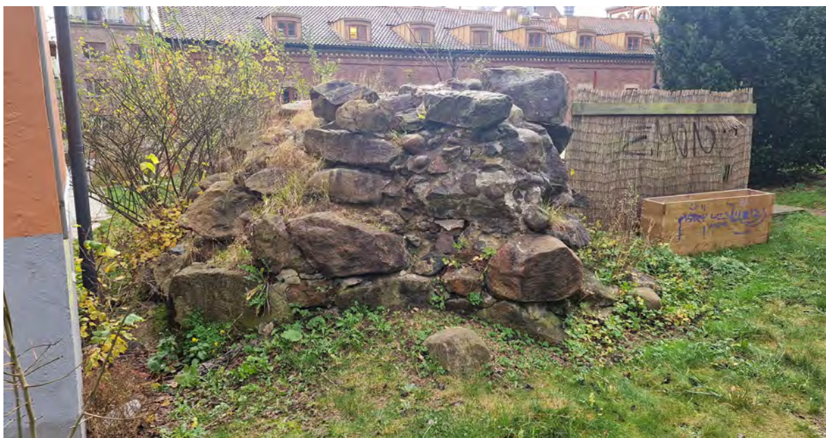
Figur 32. Objekt 11, rester av kasemattens nordöstra hörn. Mot söder.
