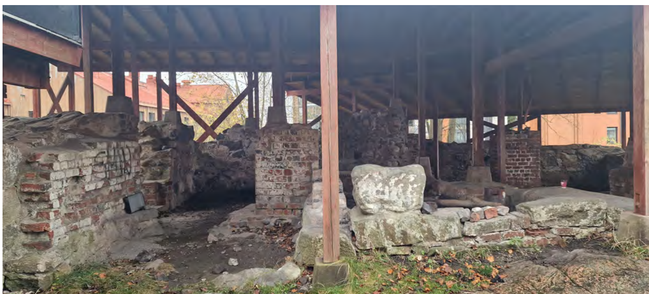
Figur 58. Foto av slottslämningarna Objekt 23 under det norra skyddstaket. I bilden syns yrtorna mellan murarna som tidigare haft golv men som under de senaste tjugo åren blivit uppbrutna och förstörda. Mot öst.
