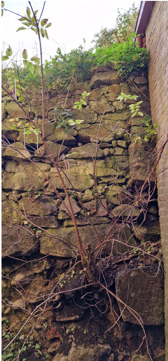
Figur 10. Objekt 1 samt utbyggnaden från porterbryggeriet/hotellet. Utbyggnaden verkar vara anpassad för att stötta och hålla emot muren. Mot sydväst.
