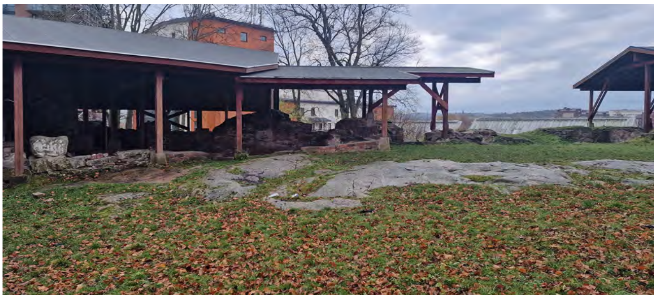
Figur 57. Översiktsfoto av slottslämningarna Objekt 23 under det norra skyddstaket. I bildens framkant syns delar av borggården Objekt 24 som gräsyta och flackt berg. Mot sydost.
