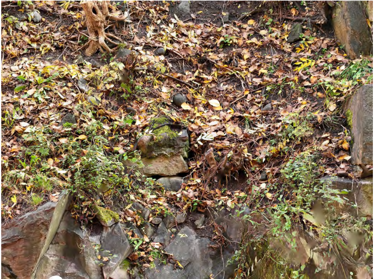
Figur 45. Foto hämtat ur 3D-model. Stenkonstruktion Objekt 18. Mot nordväst.
