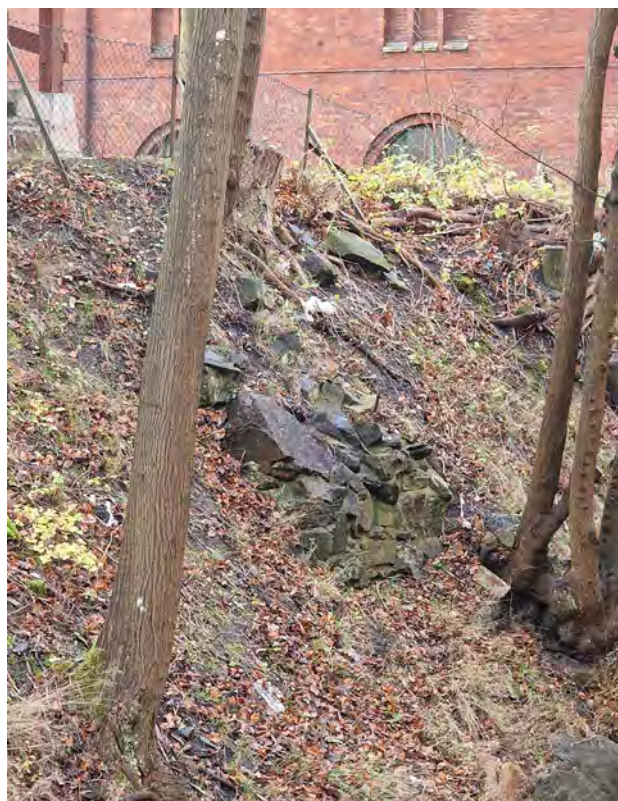
Figur 43. Objekt 15, stenmur. Mot sydväst.
