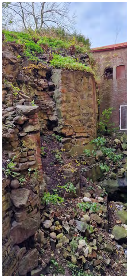
Figur 13. Foto hämtat ur 3D-model. Föreställer objekt 1 och 2 mot S. Till höger i bild syns den restaurerade östra delen av objekt 1. I botten tycks muren vara ingjuten i betong. I ytan av betongen syns rester efter formbyggnadsträ. Gjutningen tycks var gjord i tre separata nivåer ovanpå varandra. I vänstra halvan av bilden återges Objekt 2, tegel- och stenmur. Murens släta del, centralt i bilden, är restaurerad och består av två modernare tegelvarianter blandat med mellanstora stenar. Över denna del syns ett parti innehållande naturstenar blandat med äldre medeltida stortegel. Mellan stenar och tegel tycks det finnas rester av kalkbruk. I det här partiet har det skett jordras. Mot sydost.
