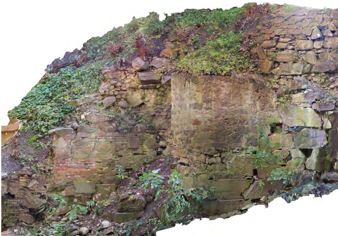
Figur 13. Foto hämtat ur 3D-model. Föreställer objekt 1 och 2 mot S. Till höger i bild syns den restaurerade östra delen av objekt 1. I botten tycks muren vara ingjuten i betong. I ytan av betongen syns rester efter formbyggnadsträ. Gjutningen tycks var gjord i tre separata nivåer ovanpå varandra. I vänstra halvan av bilden återges Objekt 2, tegel- och stenmur. Murens släta del, centralt i bilden, är restaurerad och består av två modernare tegelvarianter blandat med mellanstora stenar. Över denna del syns ett parti innehållande naturstenar blandat med äldre medeltida stortegel. Mellan stenar och tegel tycks det finnas rester av kalkbruk. I det här partiet har det skett jordras. Mot sydost.
