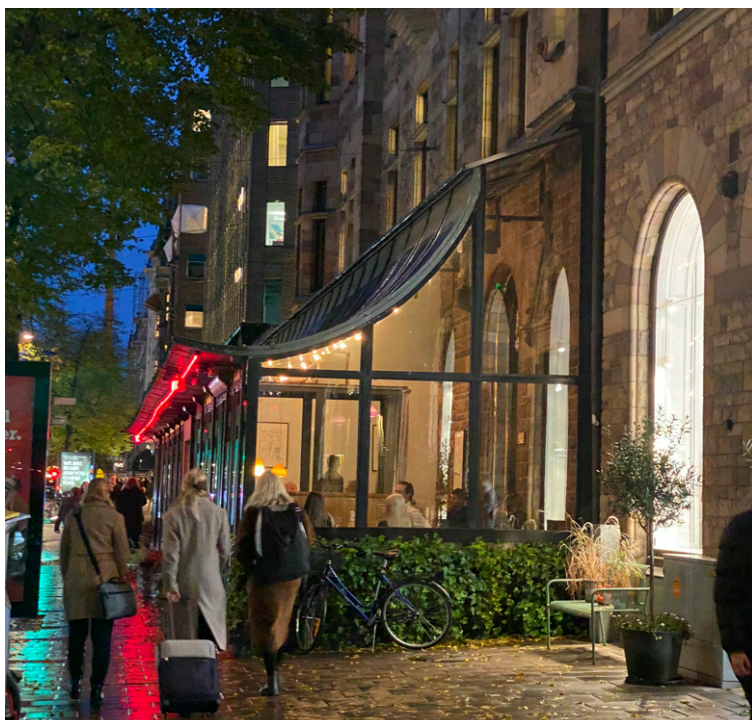
Permanent veranda med transparenta glasväggar och koppartak.
