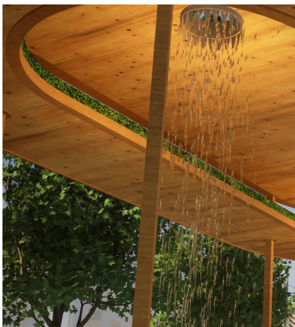
Undertak av trä och droppnäsa.
