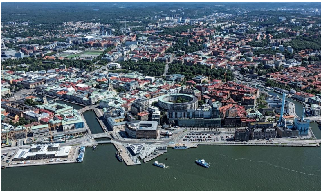
Figur 23. Flygfoto med pågående sjöfartstrafik i Göta älv, där Packhuskajen och Stora Hamnkanalen syns till vänster i bild.
