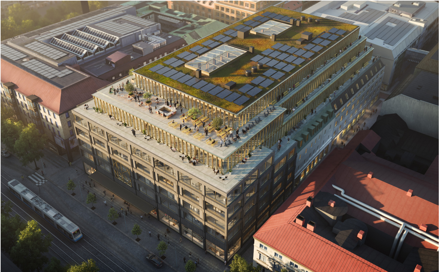
Flygvy från sydväst. Atriernas två lanterniner tecknar sig på yttertaket, som här är belagt med sedum och solceller. Därutöver tillkommer ett antal tekniska installationer.
