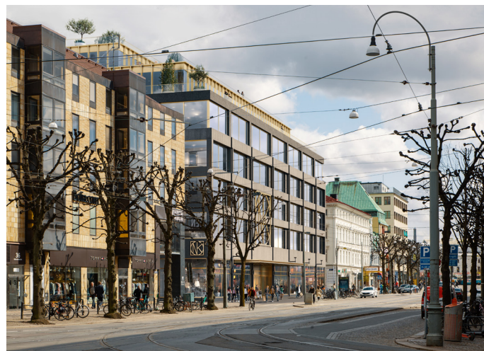
Vy från Östra Hamngatan söderut med tillbyggd våning och påbyggnad
