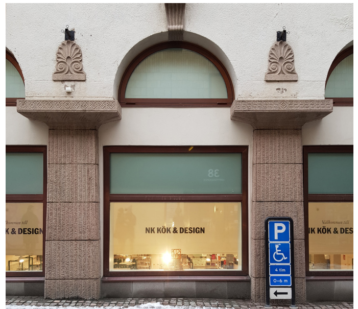
Hus C med det 2013-2017 återställda fasadlivet mot Drottninggatan
