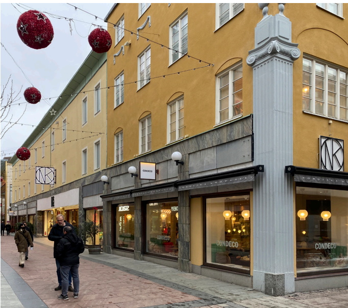
Hus F längs Fredsgatan med på 80-talet tillkommen marmorbeklädnad av murpelare och fasad
