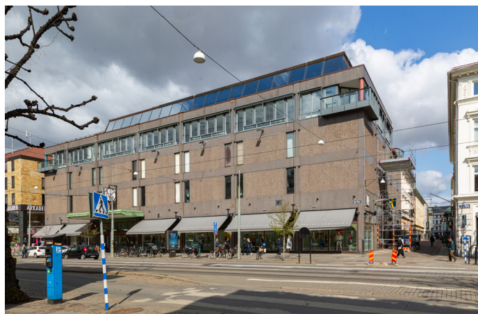
Dagens fasad mot Östra Hamngatan
