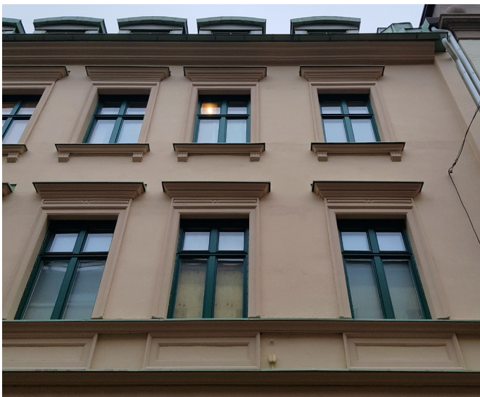
Gatufasaden är utförd som en kraftigt förenklat pastisch av den tidigare byggnaden
