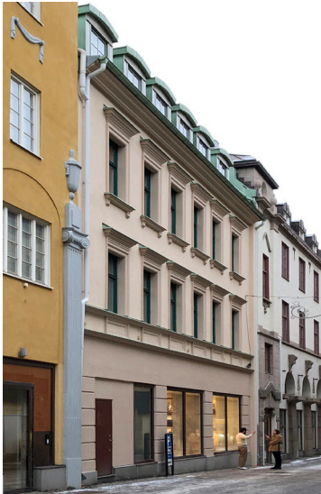
Hus A:s fasad längs Drottninggatan
