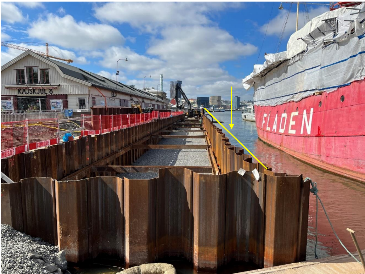
Figur 5. Pågående arbete med etapp 2. Yttre (tillfällig) spant är markerad i gult. Foto: WSP 2022.
