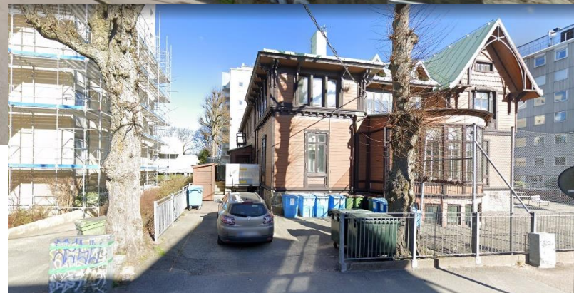
8 meters avstånd mellan höghuset och villan, Föreningsgatan Gbg.
