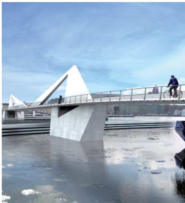
Cykelbanan på den östra sidan av bron blir 4 meter bred och gångbanan på andra sidan blir 3 meter bred.
