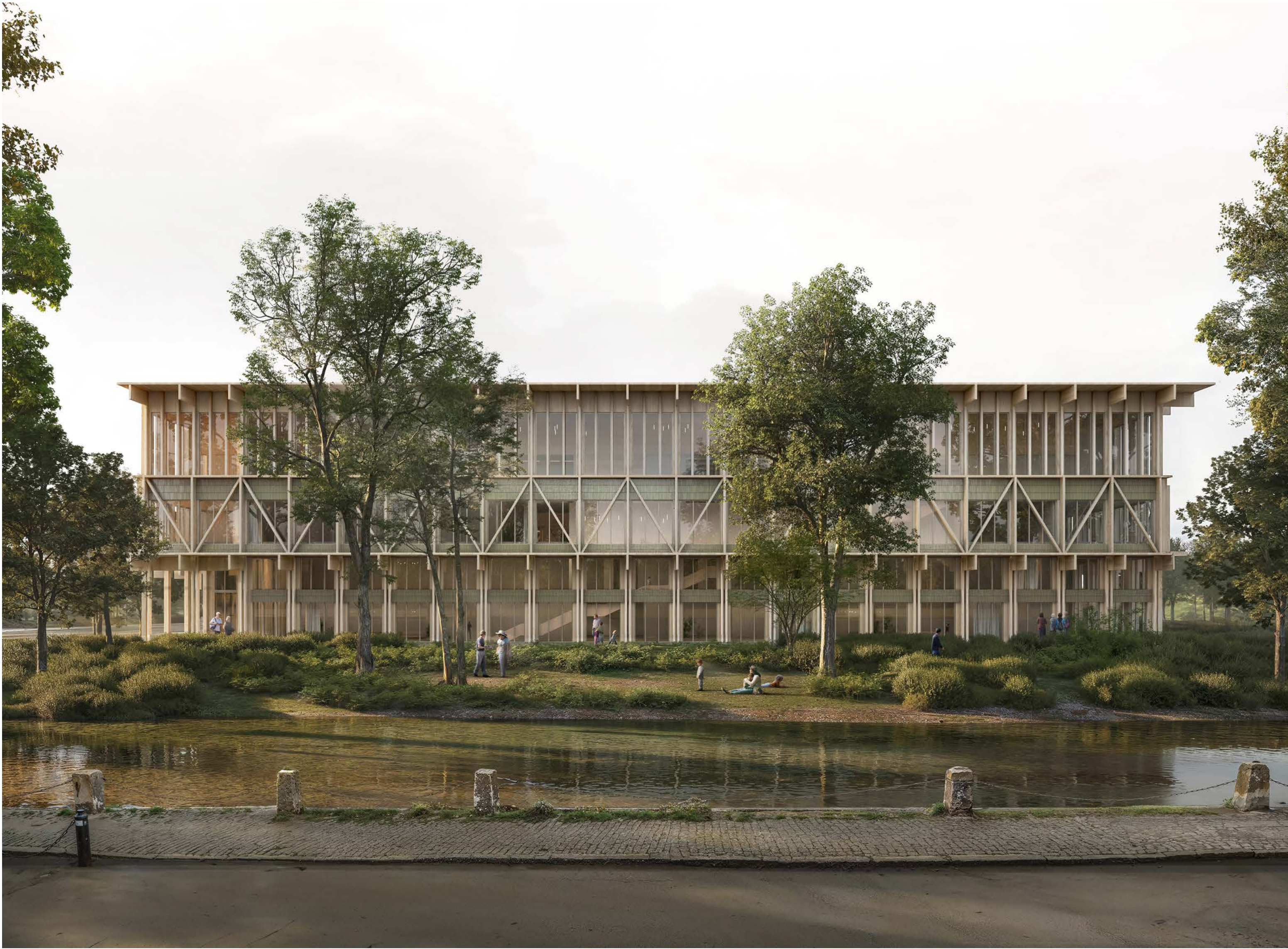
Exteriör, vy av byggnadens möte med Gädda
