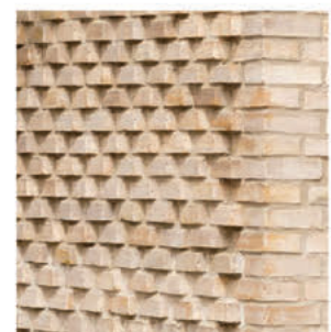
Fasad i gult tegel Återbrukat tegel med eventuell inblandning av nytt. Olika murförband skapar variation i basen.
