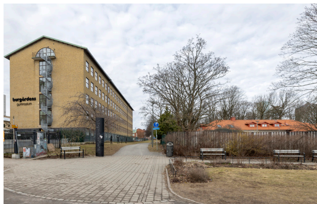
Ny entré mot Burgårdsparken vid Burgårdsgymnasiet. Foto: Thomas Johansson.
