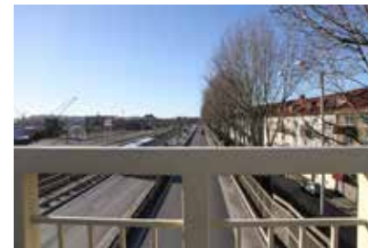
Bild: gång- och cykelbron över Lundbyleden och hamnbanan mellan Kvillestaden och Frihamnen
