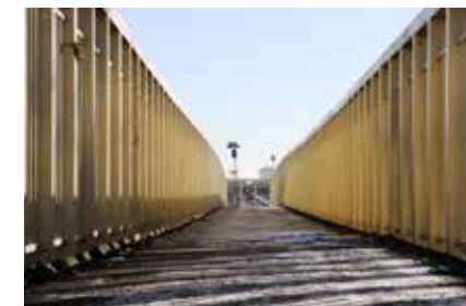
Bild: Gång- och cykelbro över Lundbyleden och hamnbanan
