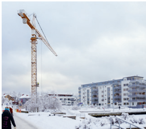
Att det byggs för fullt runt om i Göteborg märks. Här ser vi ett bostadsbygge i Sannegårdshamnen. You can tell that construction is in full swing all over Gothenburg. Pictured is a home-building project in Sannegårdshamnen.
